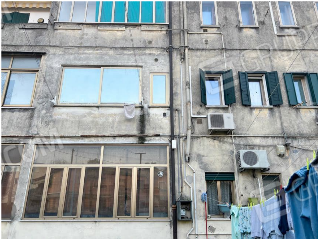
Foto n. 4 Particolare del prospetto sud-est
