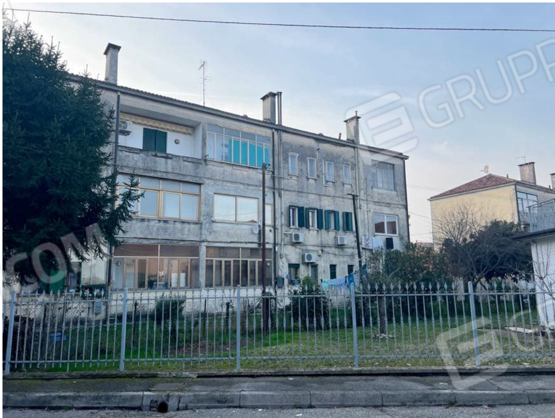
Foto n. 2 Prospetto nord-est del fabbricato su scoperto comune
