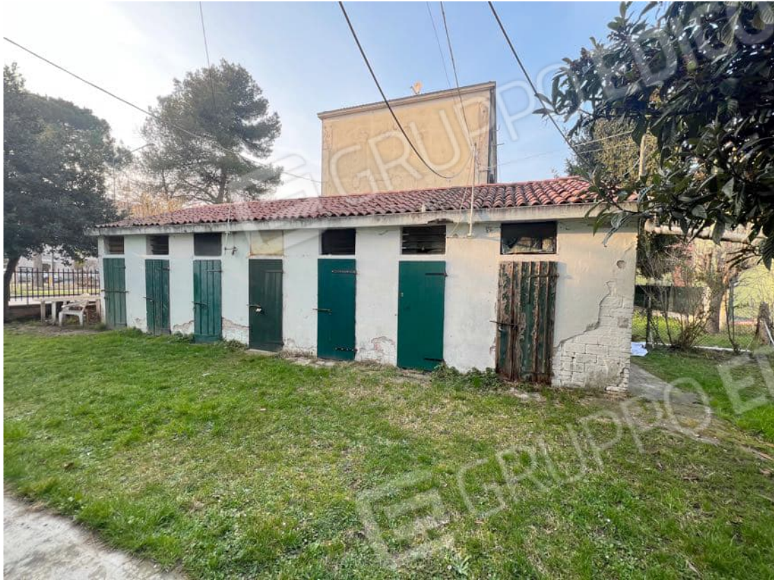
Foto n. 13 Vista fabbricato con magazzini
