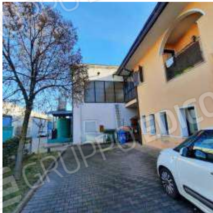
Foto 2 – scorcio prospetto Nord Ovest
