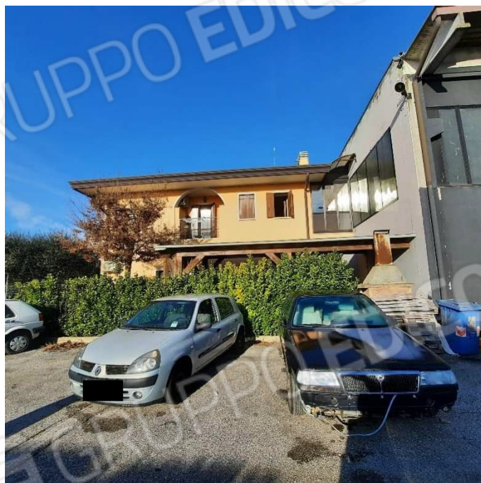
Foto 2 – scorcio prospetto sud est – ingresso uffici
