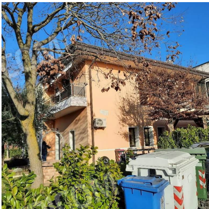
Foto 3 – scorcio prospetto sud est
