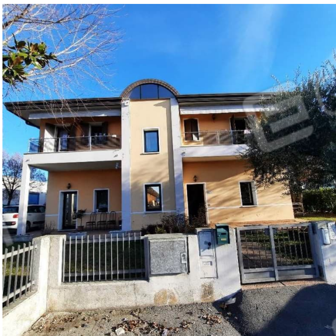
Foto 1 - Prospetto Sud Ovest – Ingresso laboratorio
