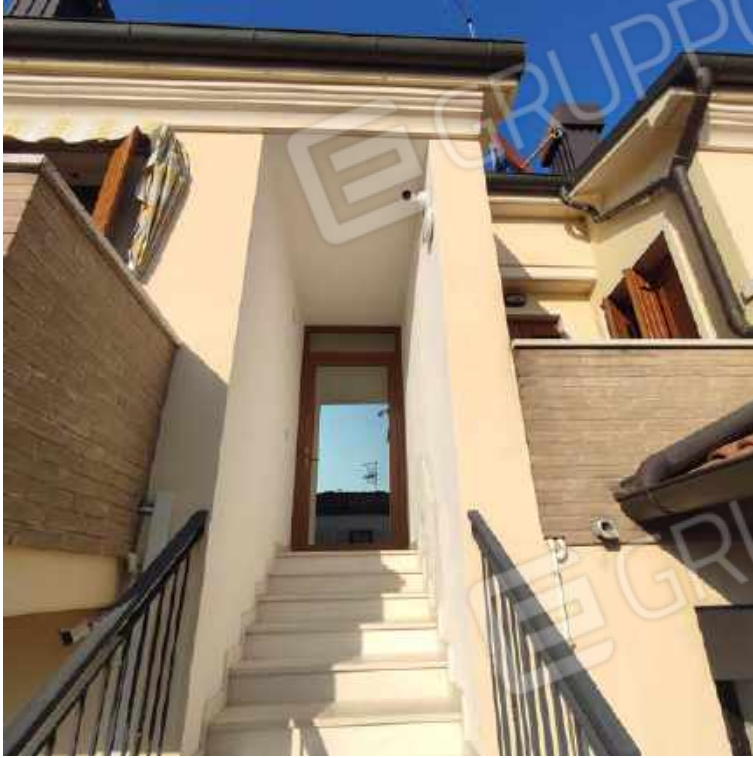
Foto n. 3 Vista su Scala Comune
