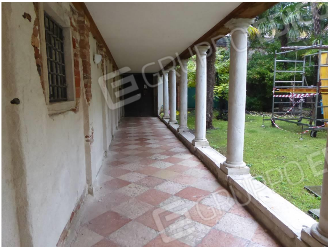
FOTO 1 – VISTA INGRESSO CONDOMINIO DA PORTICO COMUNE
