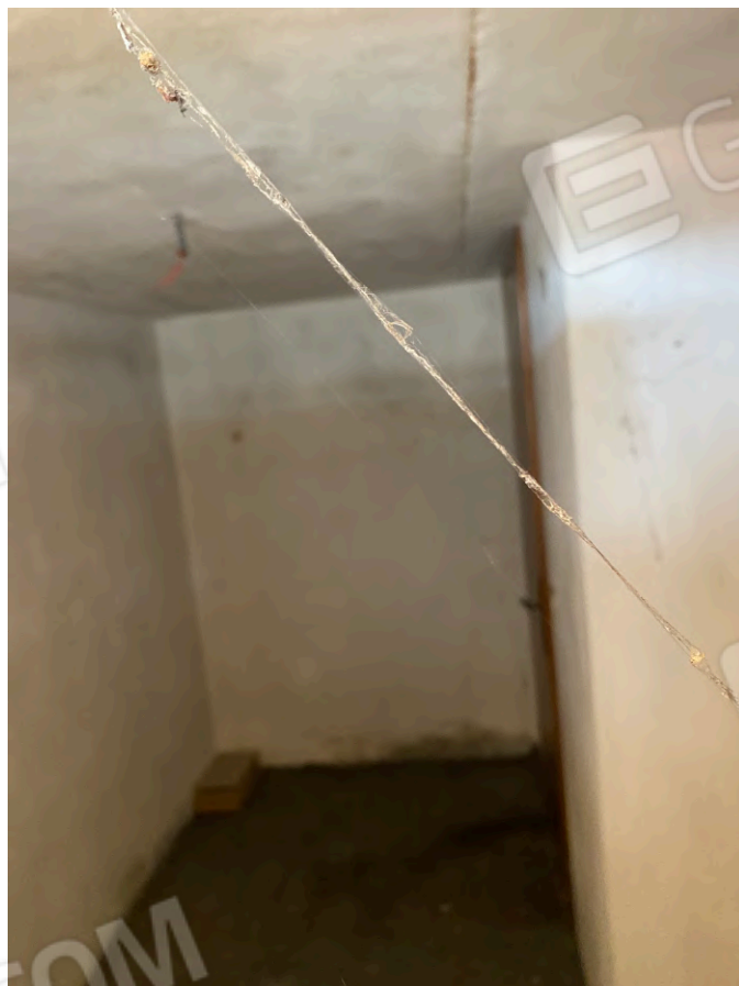
Magazzino piano terzo
