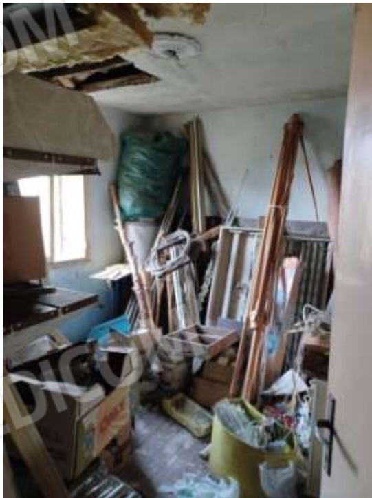
Lotto 01 – corpo A – interni primo livello
