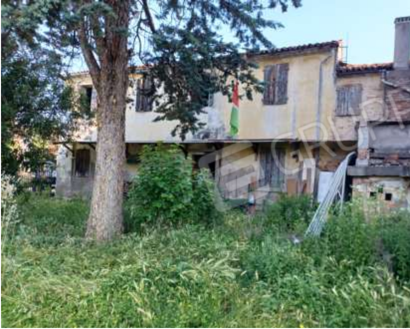
Lotto 01 – corpo A-B – abitazione unifamiliare – vista da sud
