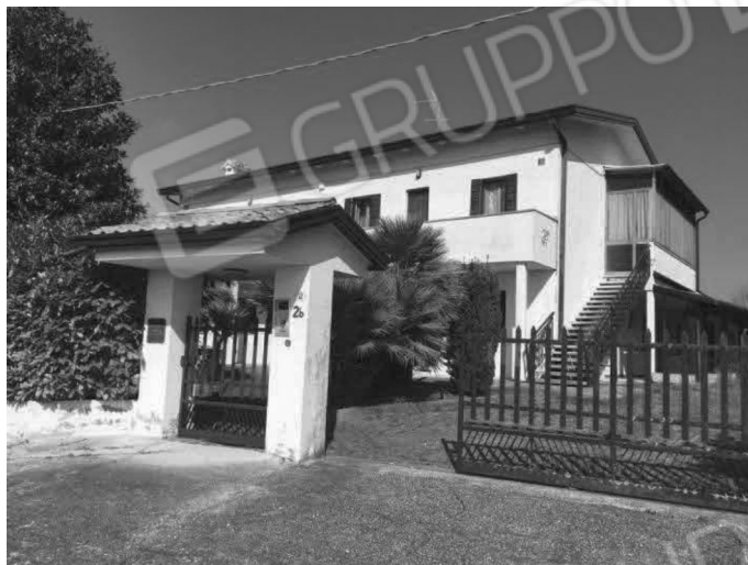
Foto 1: Vista d'insieme fabbricato residenziale lotto -A-
