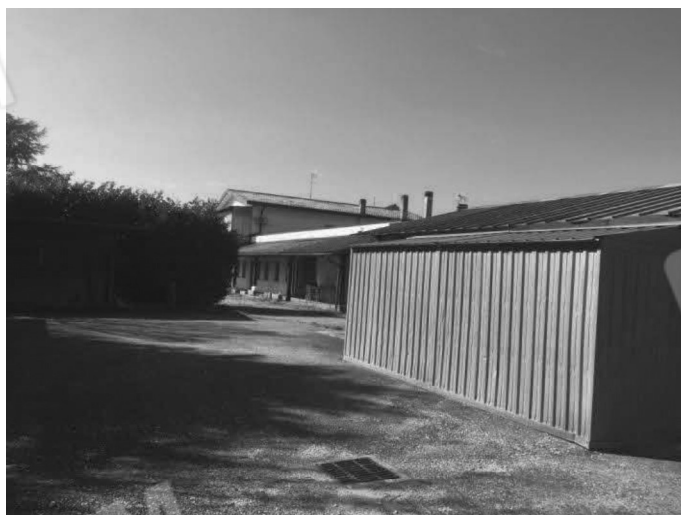
Foto 3 : Vista d'insieme pertinenze esterne previste in demolizione Lotto -A-
