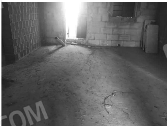
Foto 19: Fabbricato rurale lotto -D- veduta interna.
