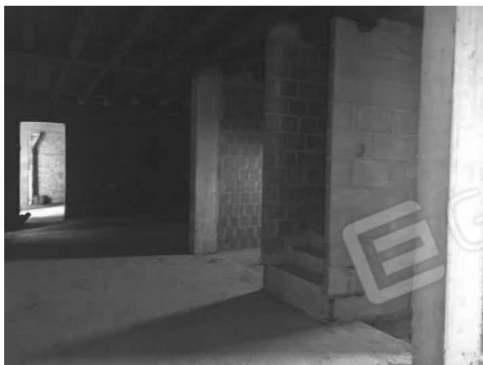
Foto 15 : Fabbricato rurale lotto -D- veduta interna.
