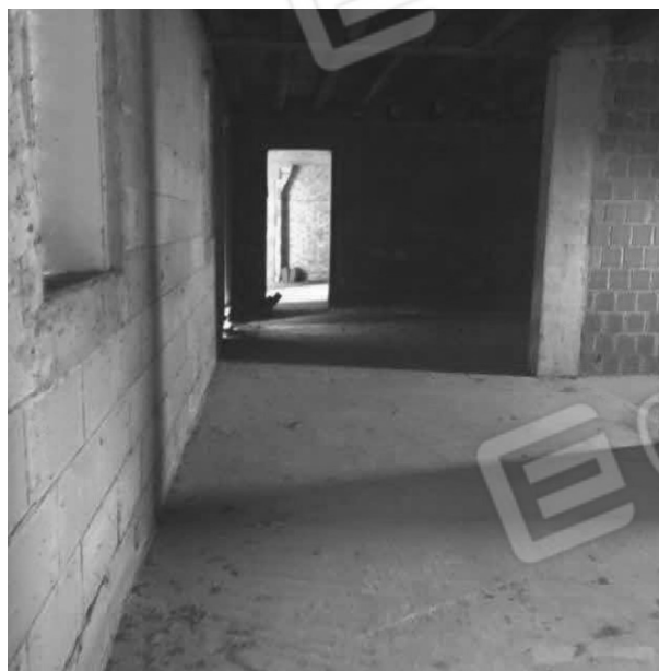
Foto 21: Fabbricato rurale lotto –D- veduta interna.
