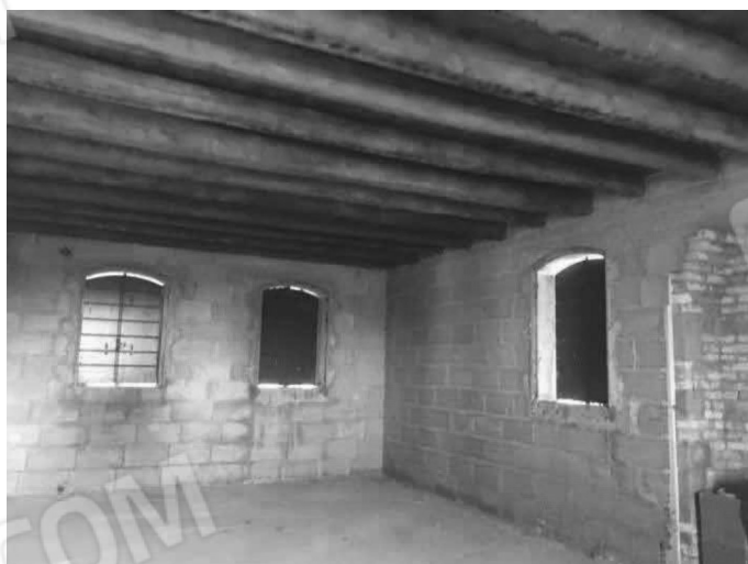
Foto 16: Fabbricato rurale lotto -D- veduta interna.
