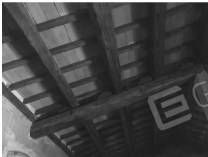
Foto 18: Fabbricato rurale lotto -D- veduta interna.
