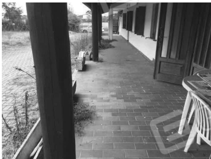
Foto 6: Fabbricato lotto -A- portico.
