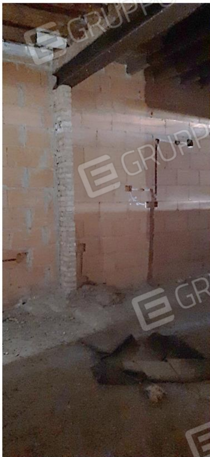
FOTO 10 – VEDUTA INTERNA PIANO TERRA ZONA SOGGIORNO
