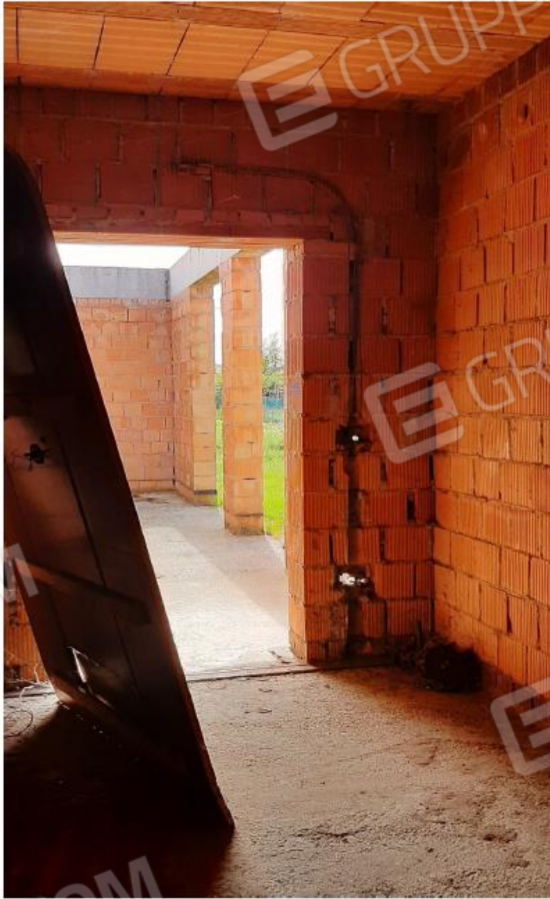
FOTO 15 – PIANO TERRA ZONA LAVANDERIA CON VISTA PORTICO
