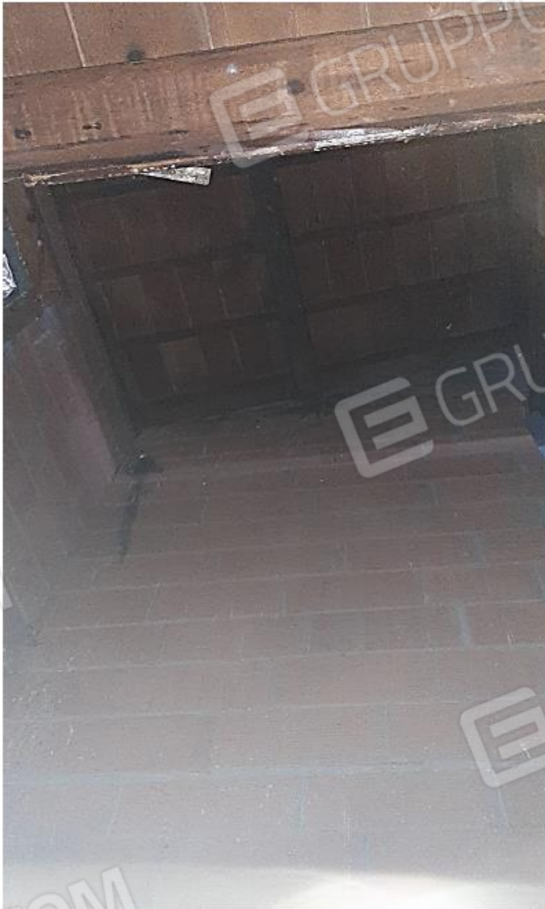
FOTO 13 – VEDUTA SOFFITTO PIANO PRIMO DA ZONA SOGGIORNO
