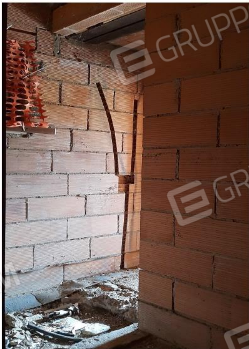
FOTO 14 – PIANO TERRA ZONA WC
