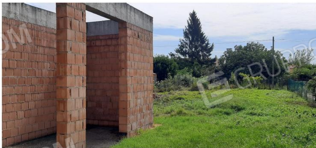
FOTO 9 – PROSPETTO CORPO ACCESSORI VISTO DA SUD
