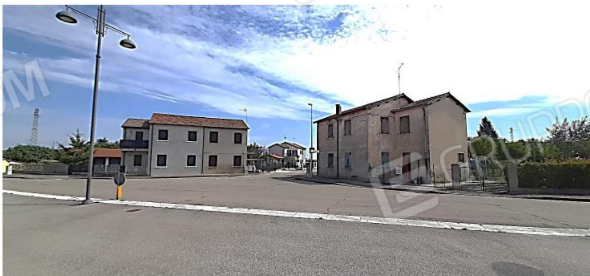
FOTO 3 – PROSPETTO SUD DA VIA VII STRADA
