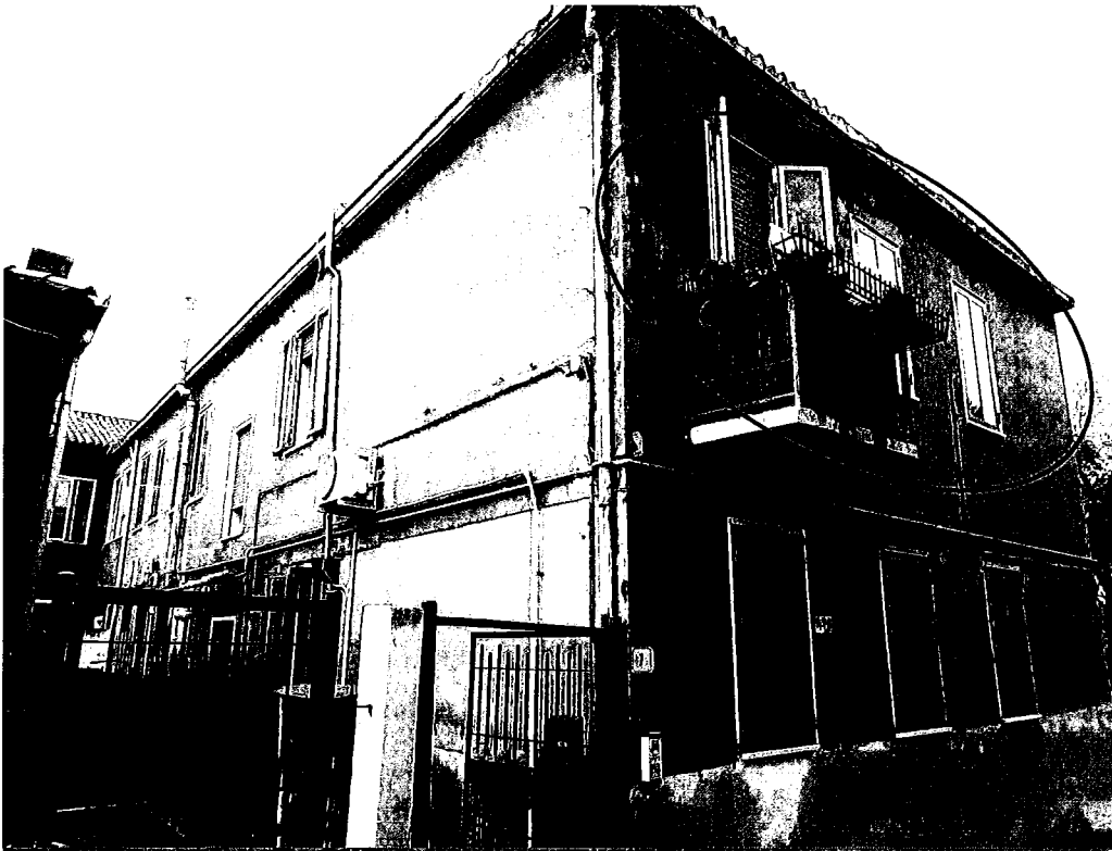
Abitazione P1 VE Murano Calle Soffiador (o Supiador) 1/B recta 7/B angolo Sud-Ovest
