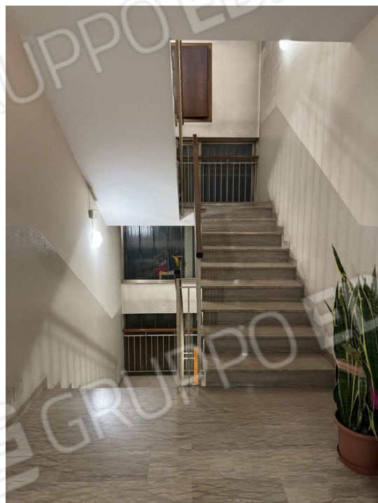
2. Vano scala condominiale
