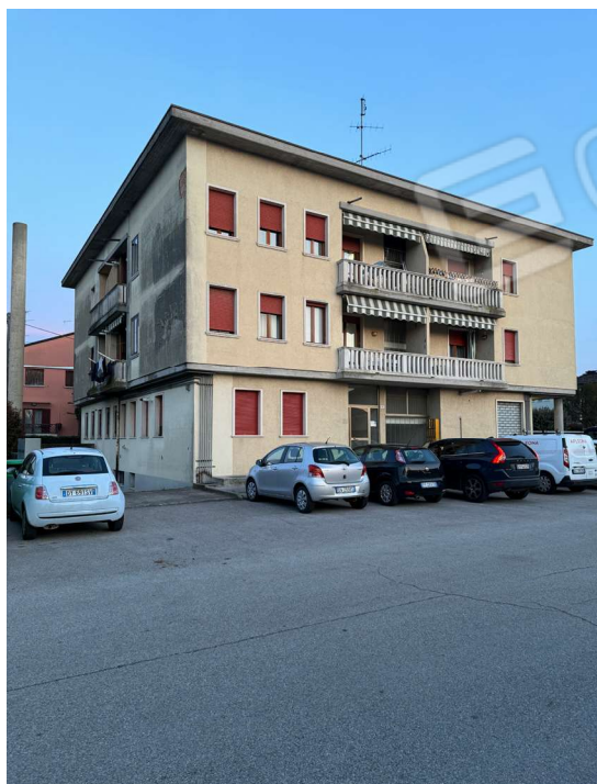
1. Vista esterna fabbricato
