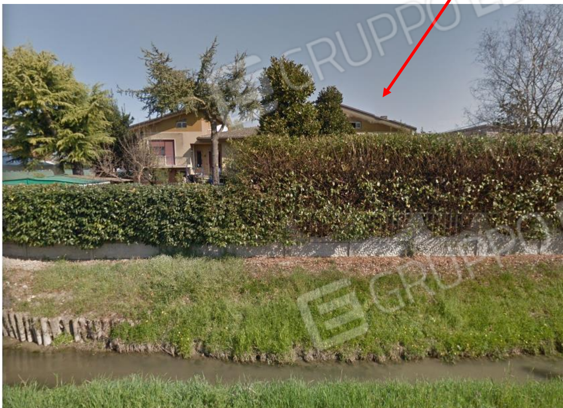
Vista dell'edificio dalla via Cavin Maggiore. La porzione pignorata è evidenziata dalla freccia
