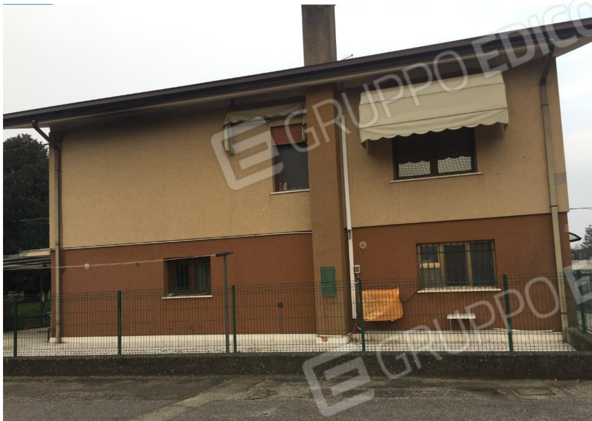
Fronte est visto dalla strada interna della proprietà adiacente
