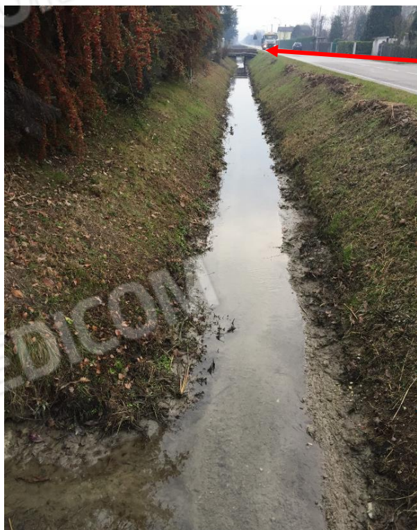
Vista del Cavin (via e canale) da ovest e del ponticello dell'accesso carraio e pedonale
