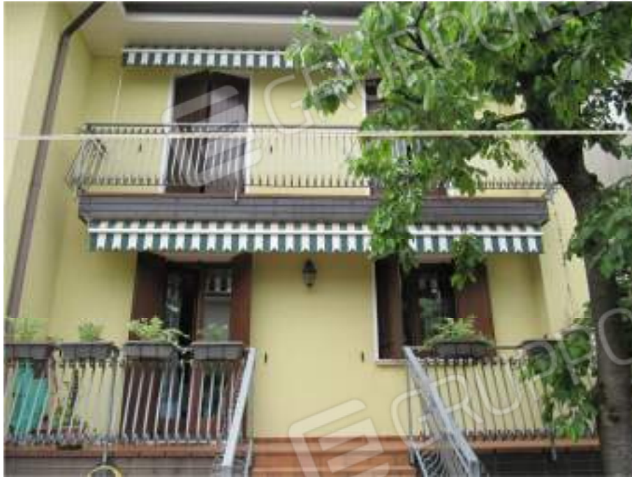
Il prospetto ovest visto dal giardino
