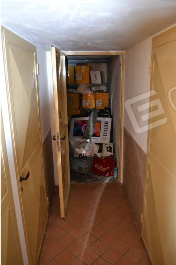
Foto 23. Accesso al garage dal vano scala condominiale
