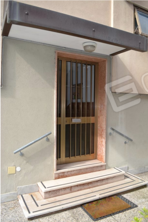
Foto 3. accesso vano scala condominiale
