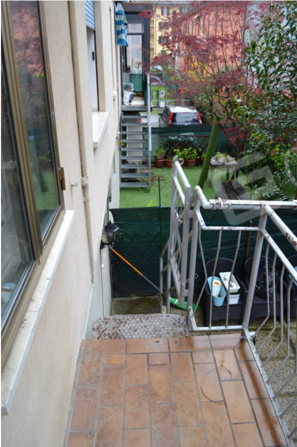
Foto 19. Terrazzino con scala accesso scoperto PT
