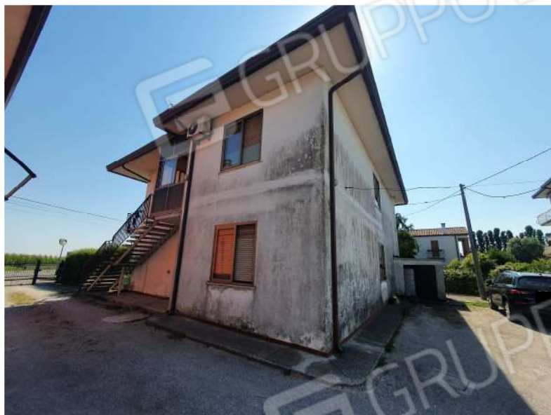
Foto n. 13: Lotto n.1 Vista Nord-Est del fabbricato del quale fa parte l'unità abitativa oggetto di pignoramento e dell'accesso carraio in reciproca servitù di passaggio con terzi.
