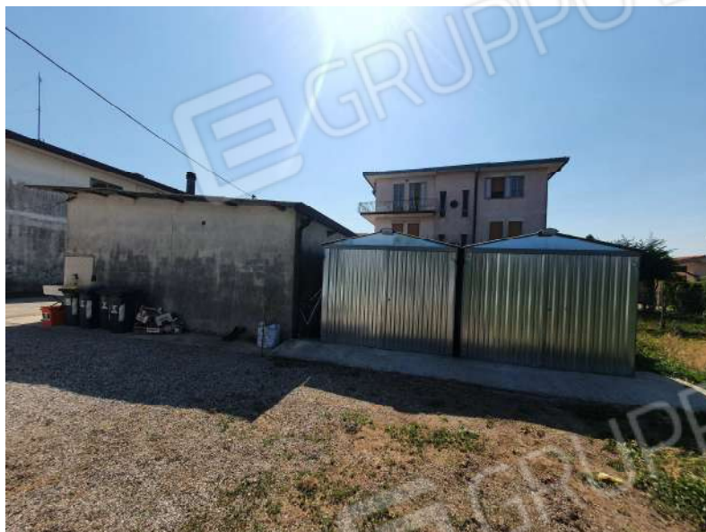
Foto n. 19: Vista Est dei box in lamiera eretti da terzi, su area comune (lotto n.1) e terreno (Lotto n.2) oggetto di pignoramento.
