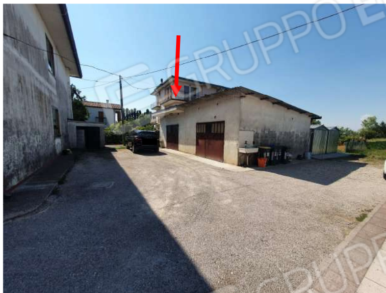
Foto n. 15: Lotto n.1 Vista Sud-Est del fabbricato ad uso garage del quale fa parte l'unità oggetto di pignoramento.
