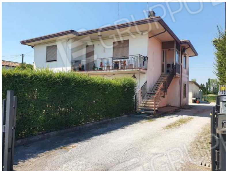
Foto n. 3: Lotto n.1 Vista Sud-Est del fabbricato del quale fa parte l'unità abitativa oggetto di pignoramento e dell'accesso carraio in reciproca servitù di passaggio con terzi.
