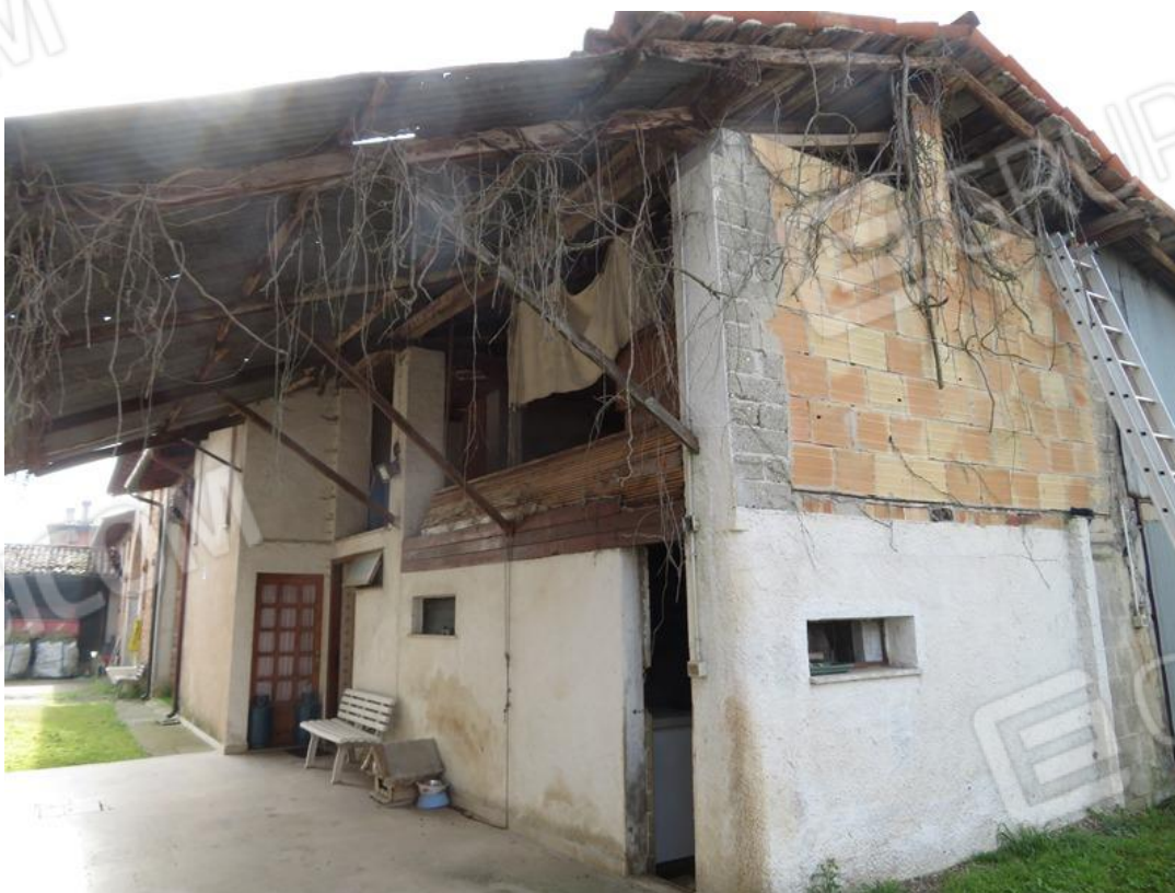
Vista del fabbricato
