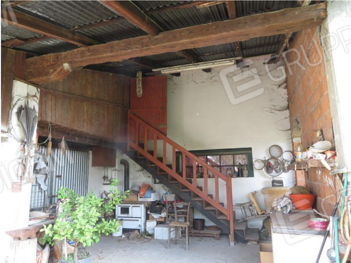
Portico e scala di accesso al piano primo
