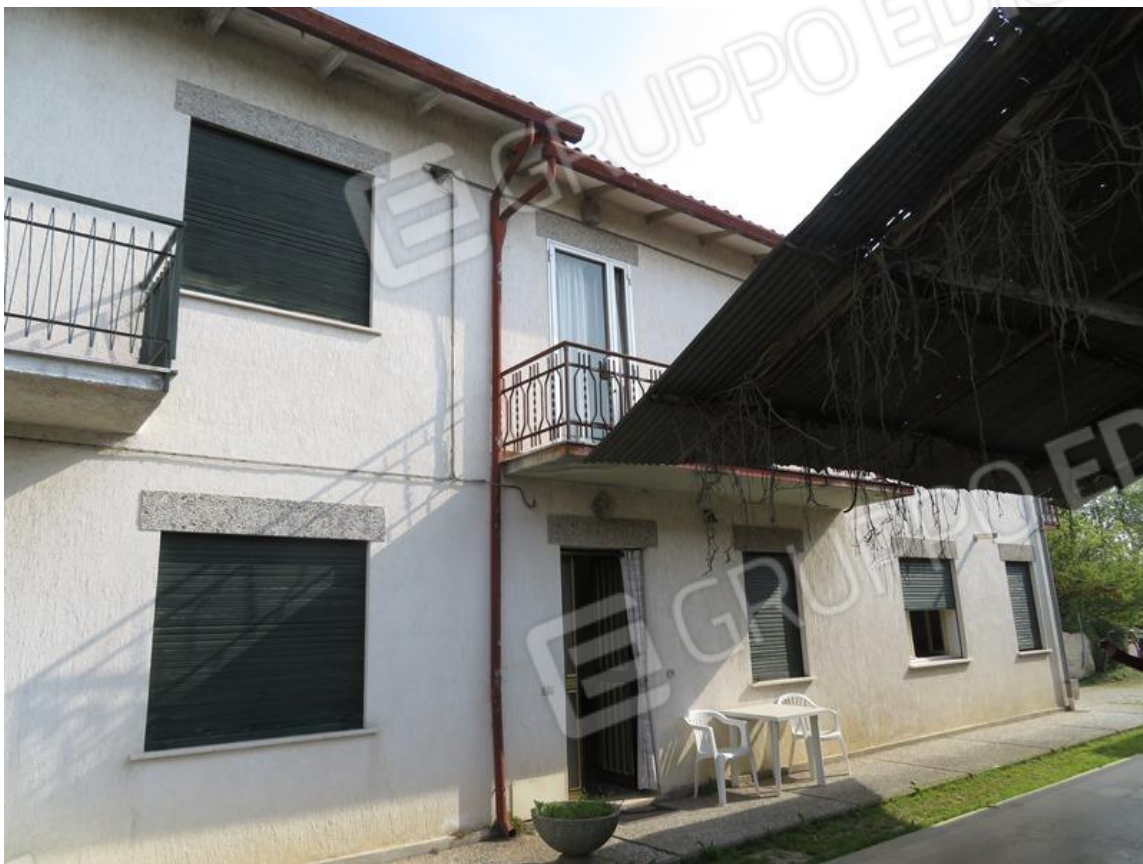
Vista del fabbricato
