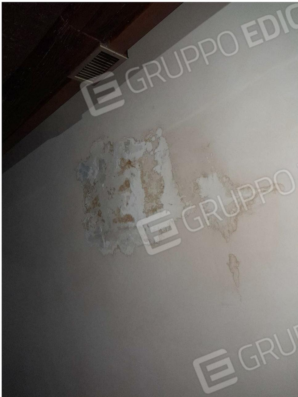
**FOTO N.22\_ Infiltrazione muro soggiorno piano terra**
