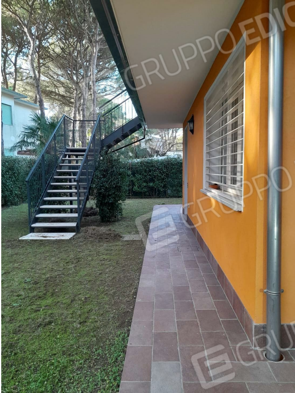
FOTO N.07_Zona scoperto esclusivo (parte pavimentata)
