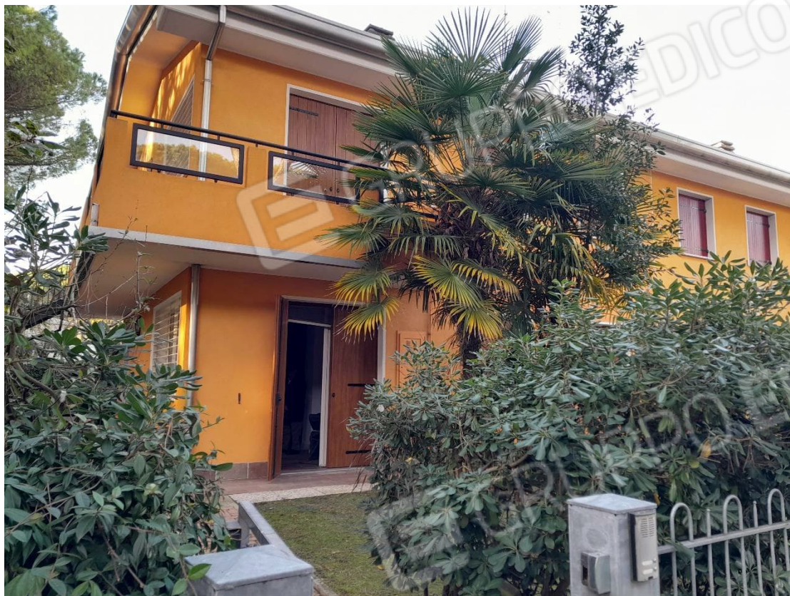
FOTO N.02_ Prospetto Est (ingresso)
