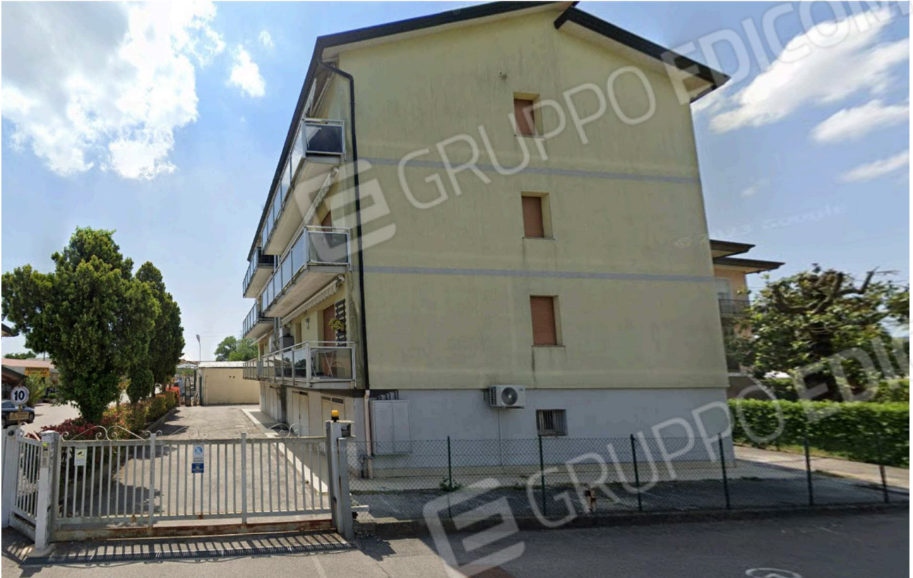
Foto 02 – Prospetto Nord – Accesso carraio da Via Triestina
