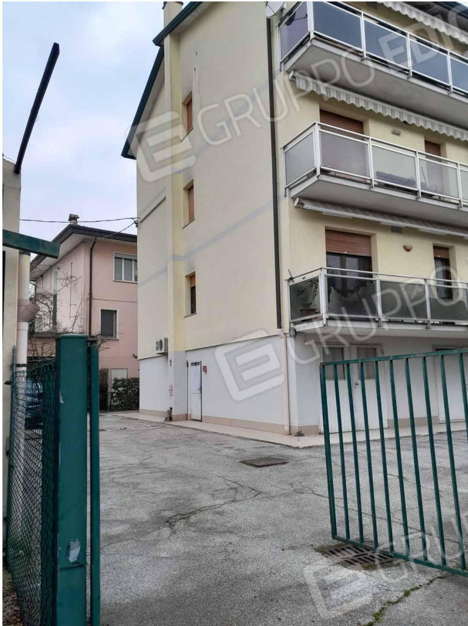
Foto 03 – Prospetto Sud-Est– Accesso carraio da strada privata
