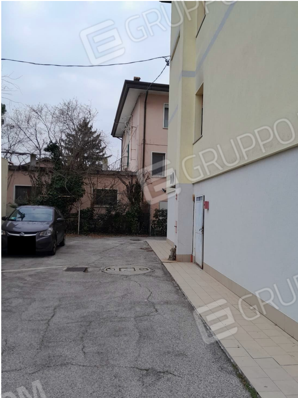
Foto 05 – Prospetto Sud – accesso CT
