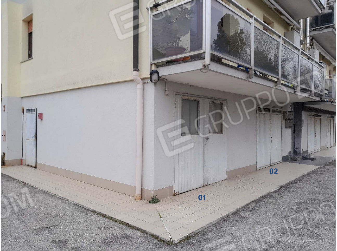
Foto 06 – Prospetto Sud-Est– accesso autorimesse in perizia
