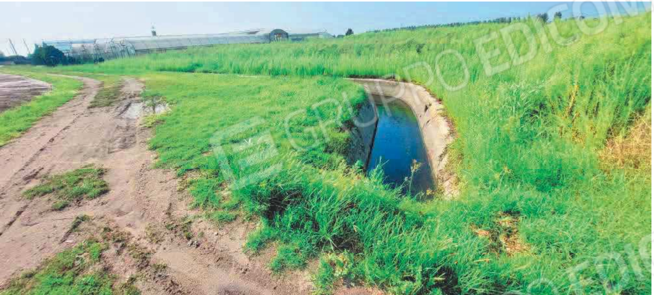
Canaletta di irrigazione consorziale (Mapp. 275)
