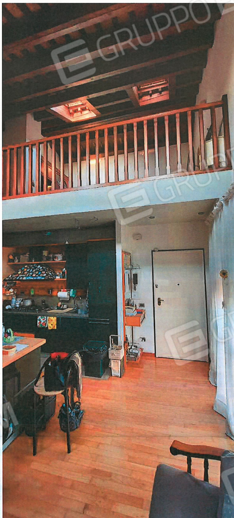
Vista dell'ingresso con indicato il soppalco abusivo
