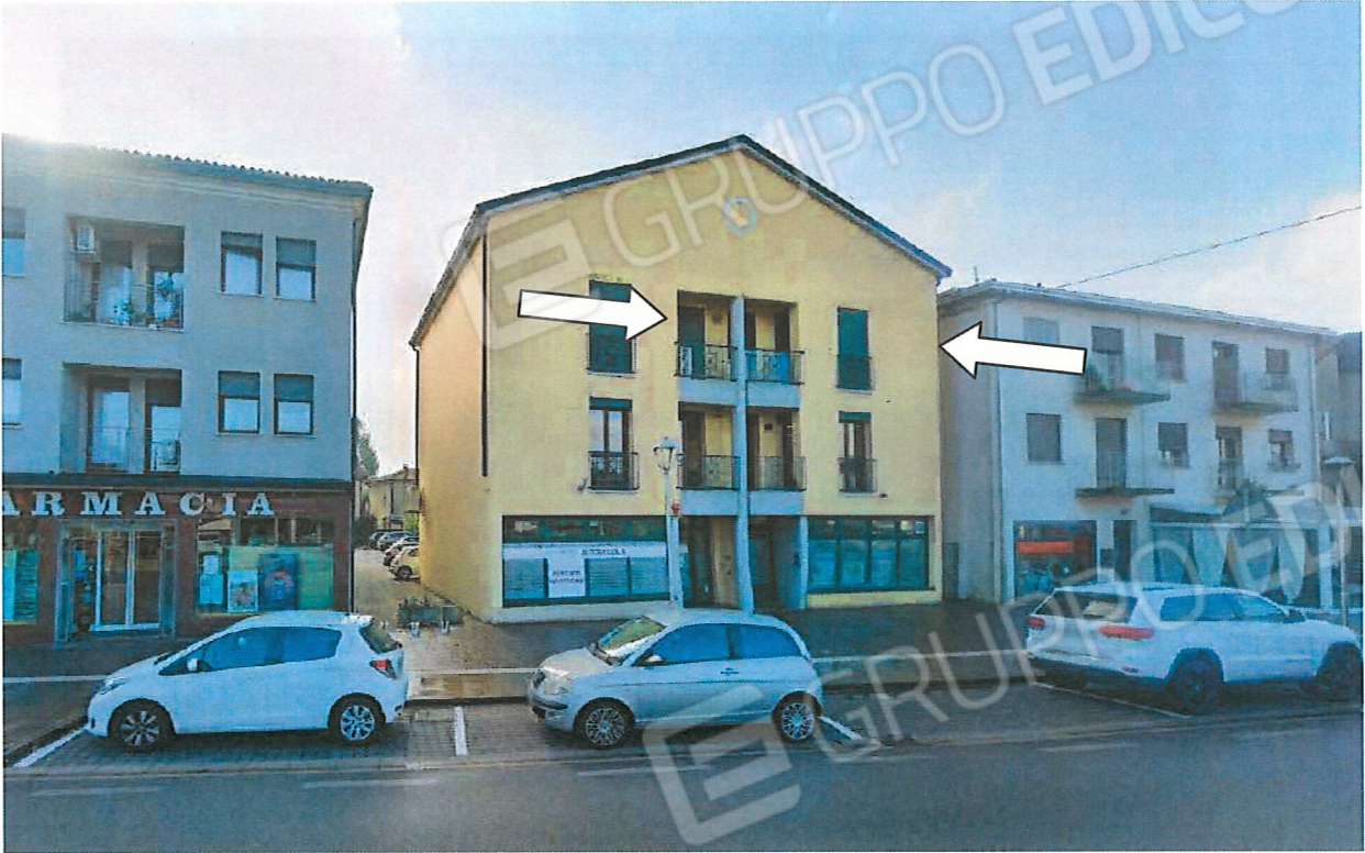
Vista dell'immobile con indicata la posizione dell'appartamento
