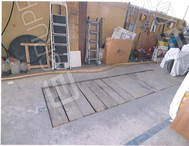
foto 11 dettaglio fossa per manutenzione mezzi
