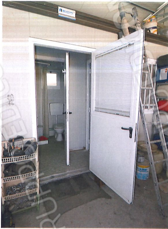
foto 13 prefabbricato servizio igienico, dettaglio
