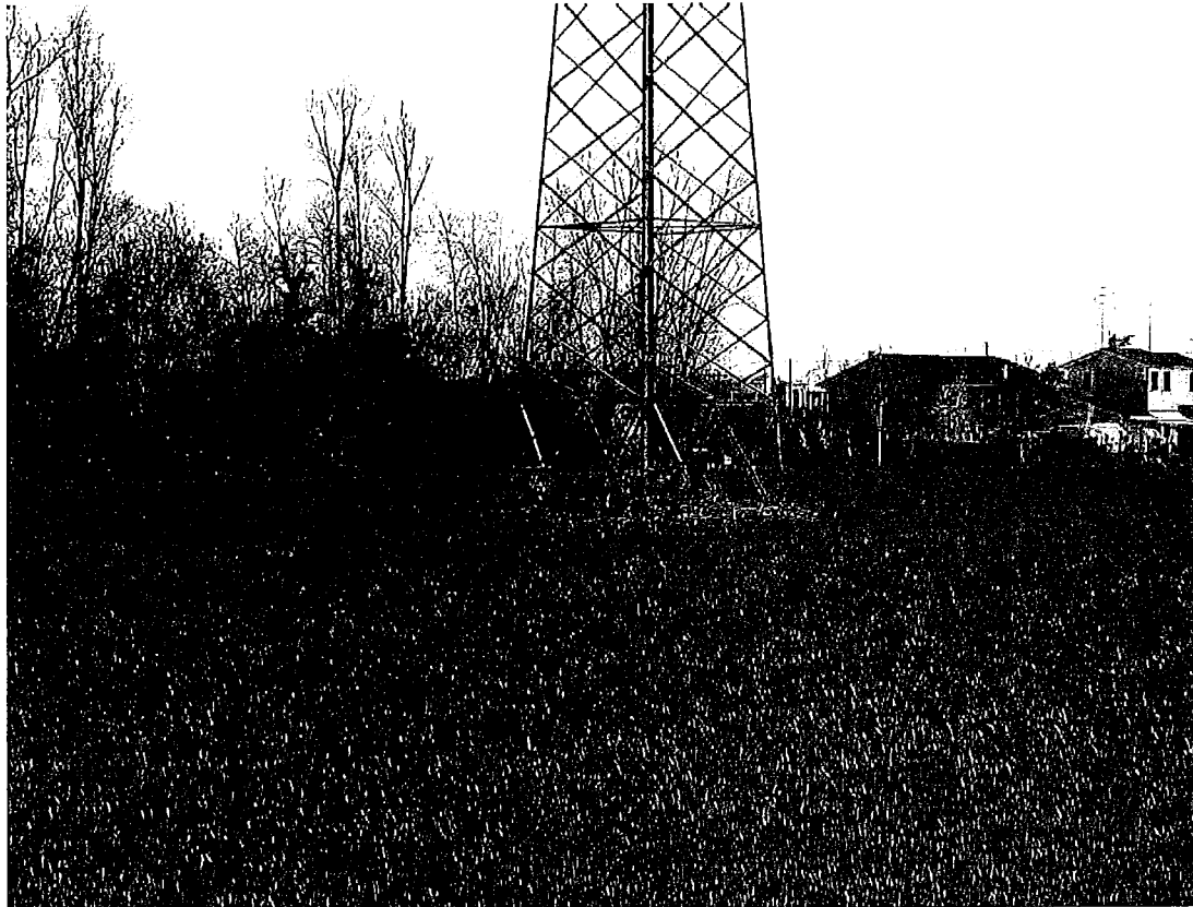
Fotografia n. 05 – Traliccio elettrico posto all'interno del Lotto
