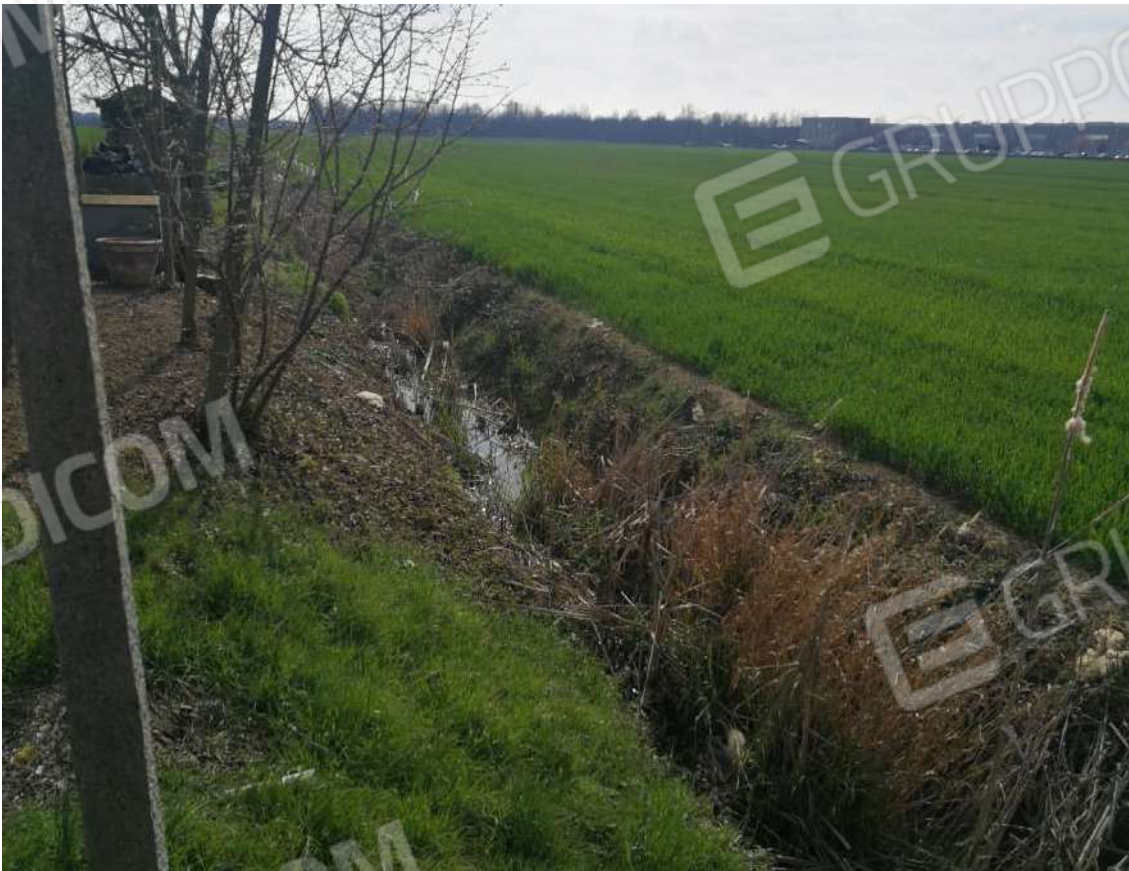
Fotografia n. 04 – Scolina al confine Ovest dei terreni
