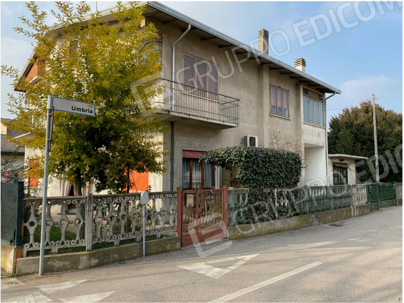
Foto del fabbricato da via Umbria
