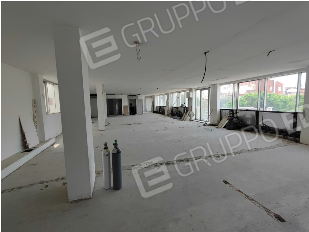
LOTTO N. 8 - FOTO 10: vista interna dell'ufficio
