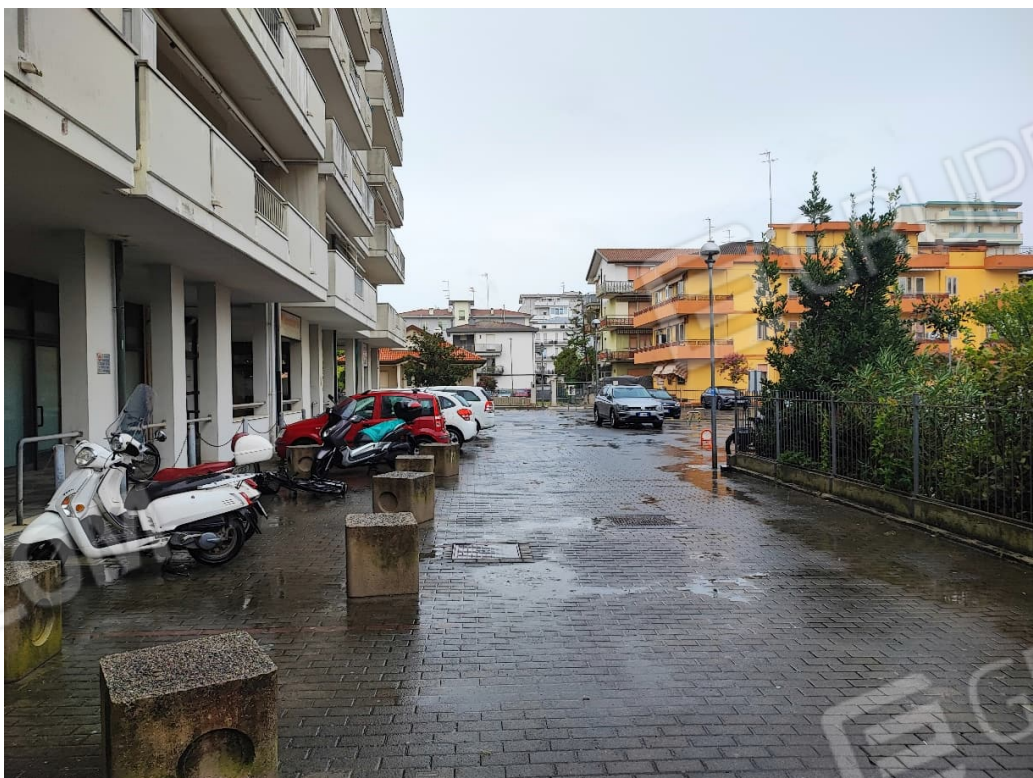
LOTTI N. 17-24 FOTO 2: vista dell'area in cui si trovano i posti auto
