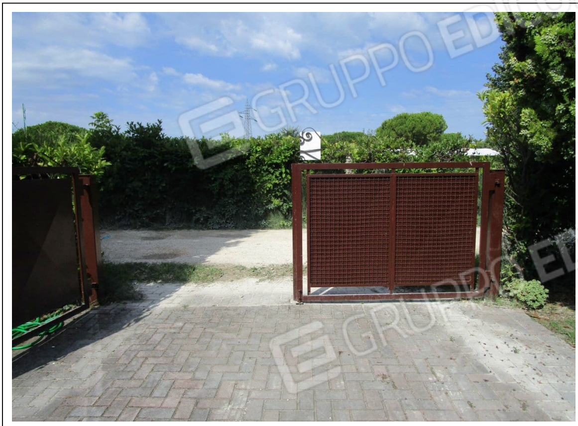
Fotogramma 6/9 – Particolare dell'accesso carraio.
