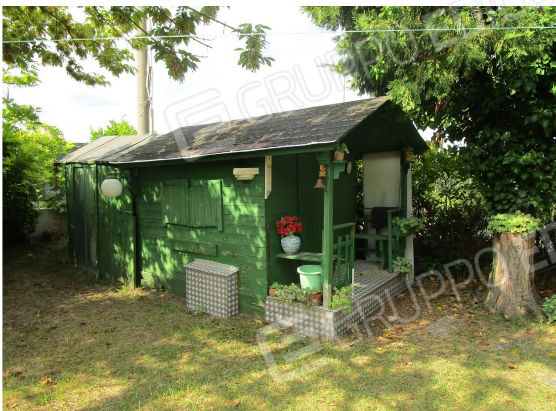
Fotogramma 8/9 – Particolare dello scoperto e casa hobby.
