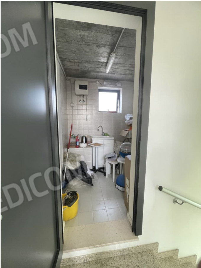
Veduta locale tecnico piano terzo
