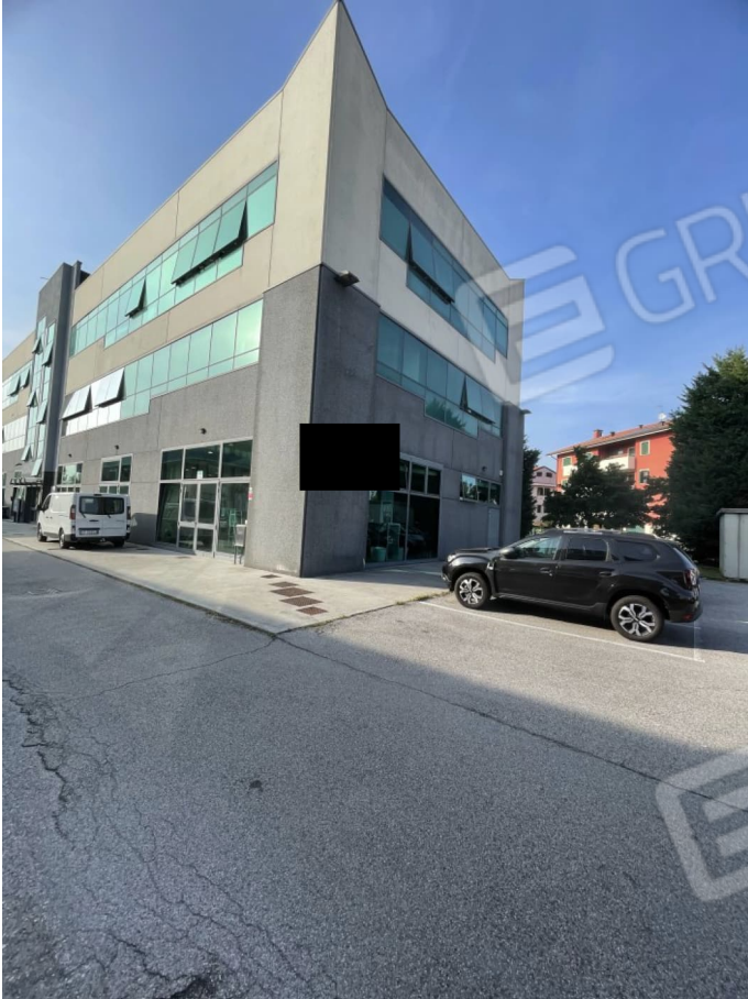
Veduta facciata lato via Milano e laterale
