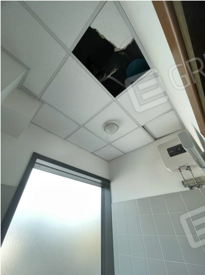
Veduta contro soffitto bagno.
