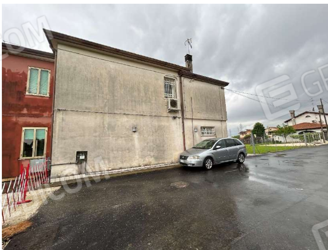
Foto 4 – Facciata su via Benedetto Veruda
