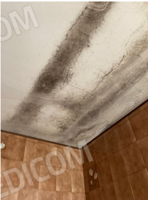
Foto n. 16-17: particolare soffitto del bagno annerito
