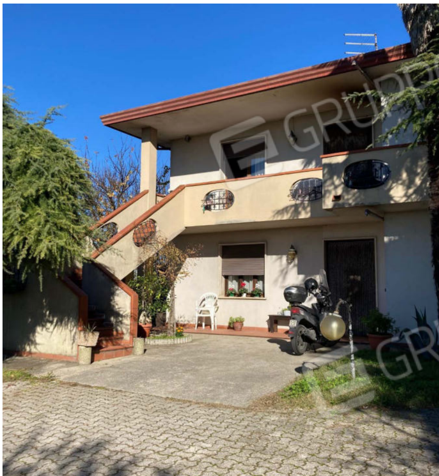
Foto n. 3: Vista scala d'ingresso al piano primo
