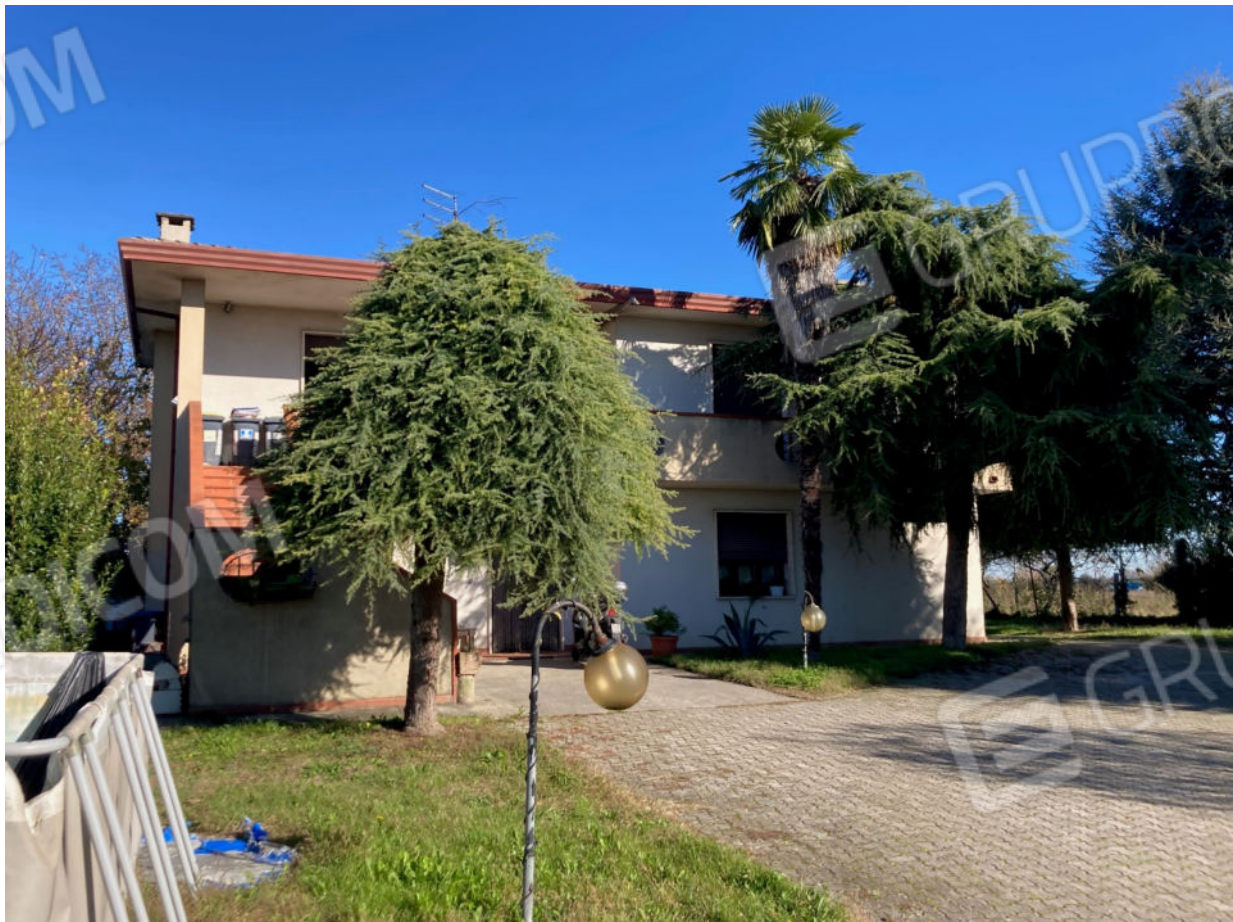
Foto n. 2: vista del fabbricato da sud
