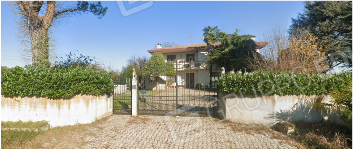
Foto n. 1: vista del fabbricato da via Rialto
