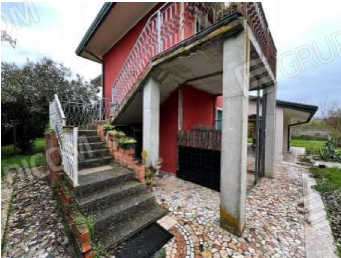
Foto 20 – accesso piano primo
