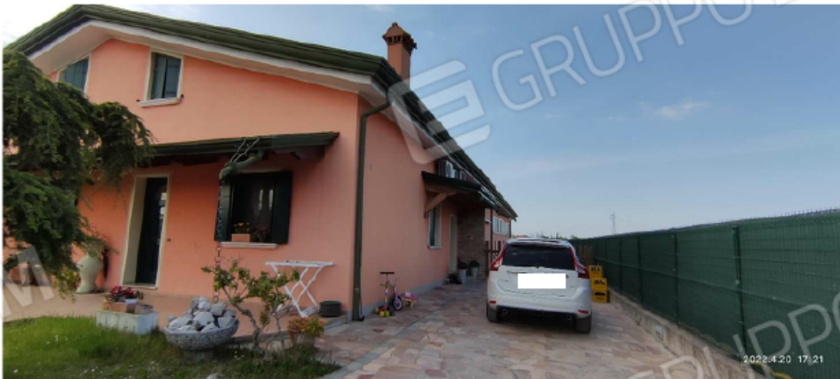
FOTO 2_ PROSPETTISUD ED EST
