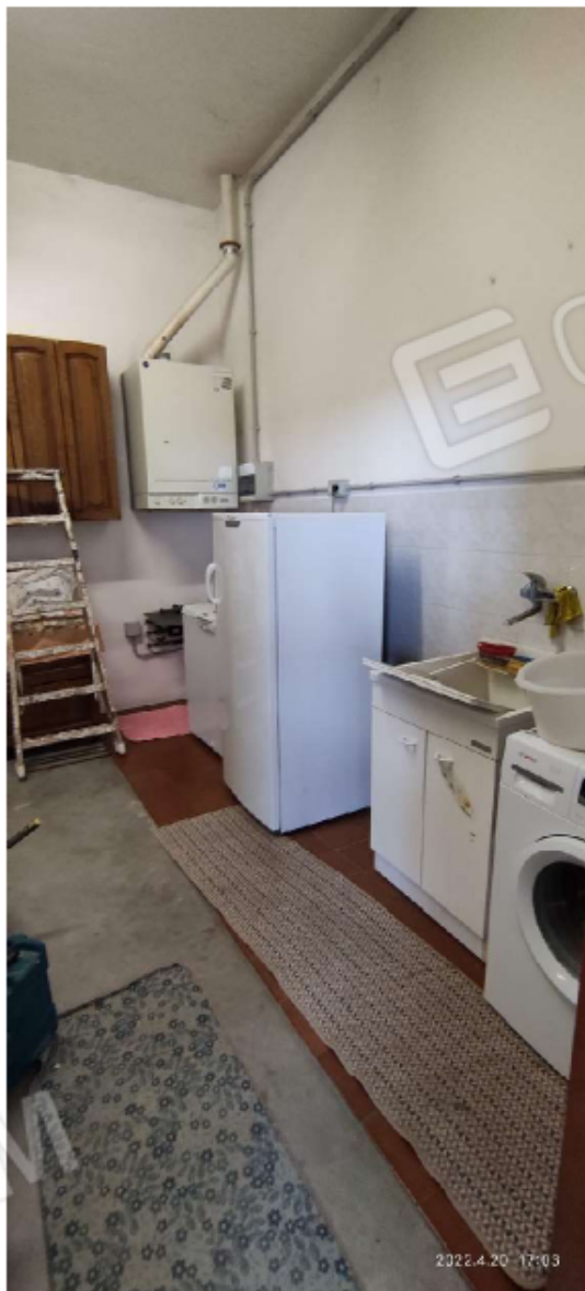
FOTO 9_MAGAZZINO AD EST
