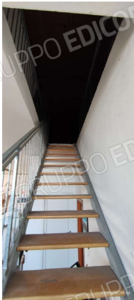
FOTO 14_SCALA DI ACCESSO AL SOTTOTETTO
