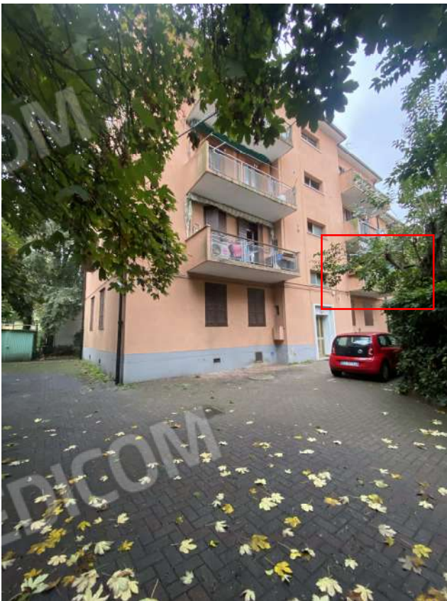
FOTO 4: Vista esterna fabbricato
