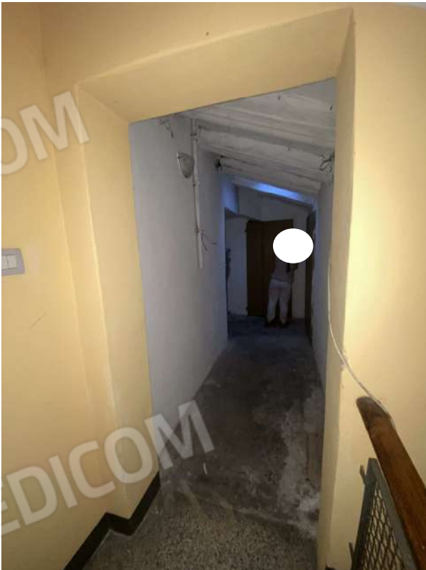
FOTO 16: Accesso locale nel sottotetto
