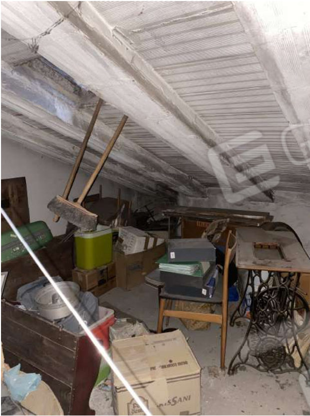
FOTO 17: Locale magazzino nel sottotetto
