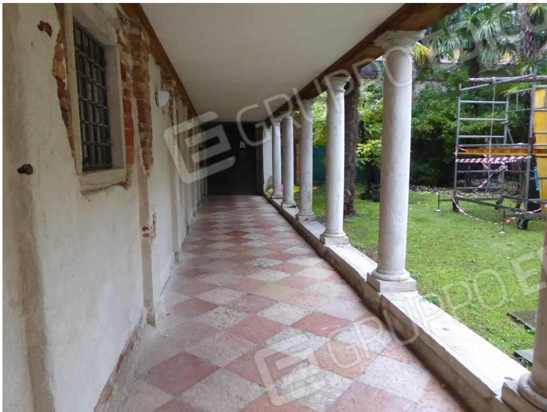
FOTO 1 – VISTA INGRESSO CONDOMINIO DA PORTICO COMUNE
