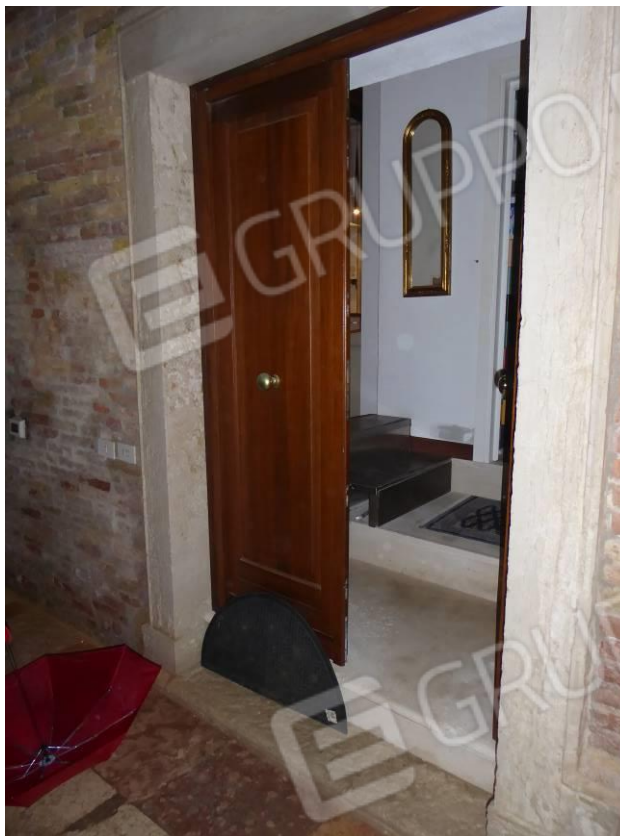
FOTO 5 – VISTA INGRESSO UNITA' IMMOBILIARE DA ANDRONE COMUNE
