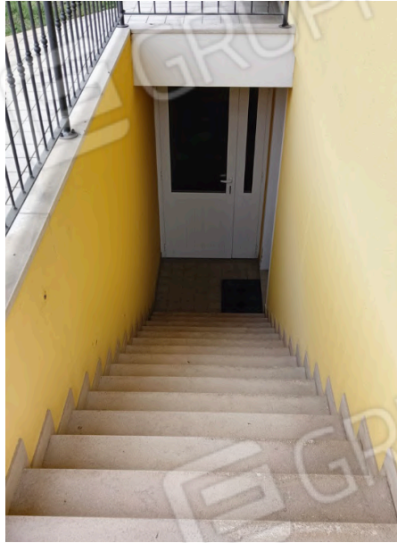
Foto 7: Scala esterna che porta al piano interrato
