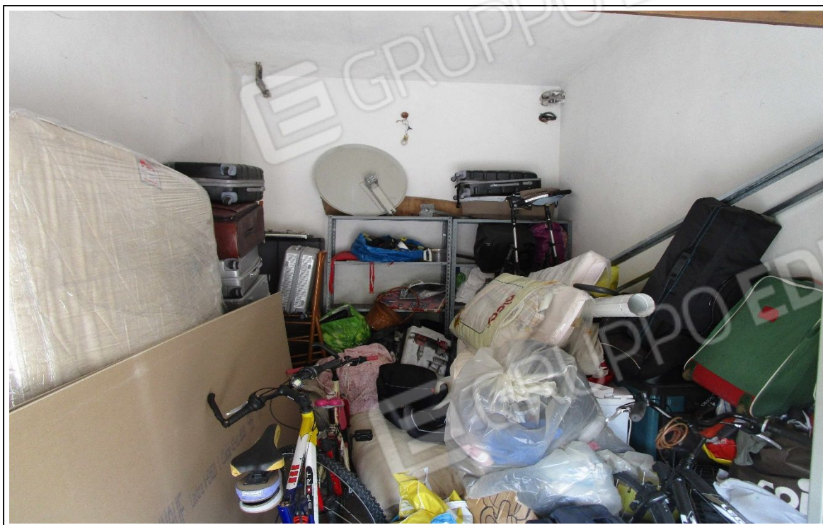
Fotogramma 2 – Particolare interno garage – tubi e impianto elettrico.
