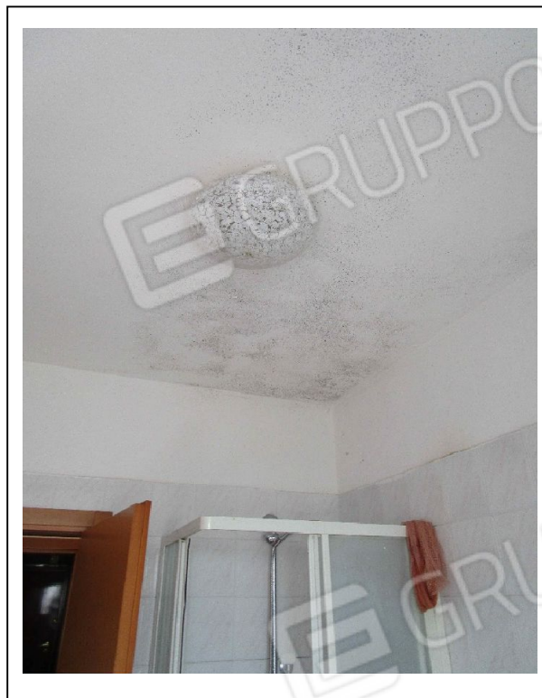
Fotogramma 11 – umidità/muffe.
