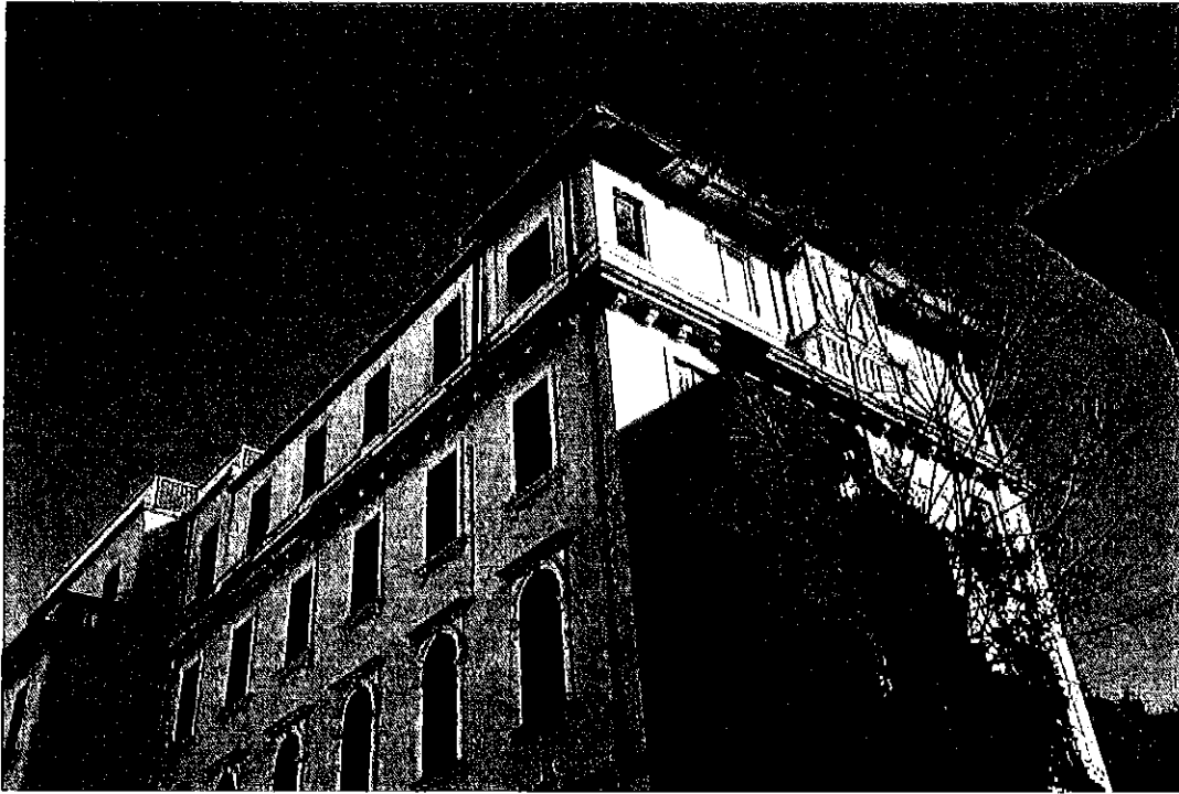
Fronte sud ovest - Gennaio 2019
