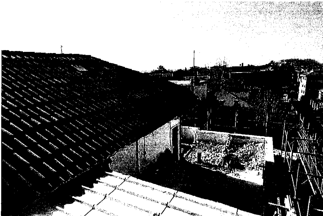
Fronte sud ovest - Marzo 2019 durante i lavori di ripristino dello stato legittimato.
