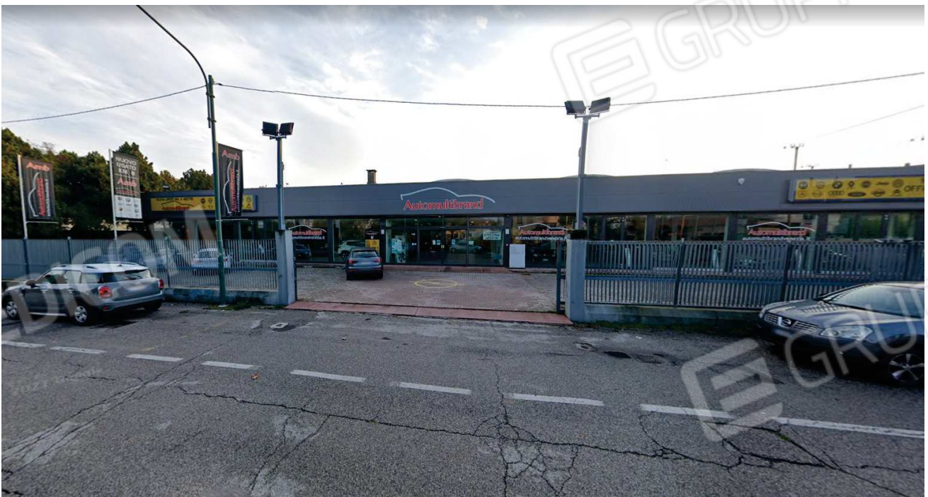
Vista del Prospetto Nord da Via Giustizia
