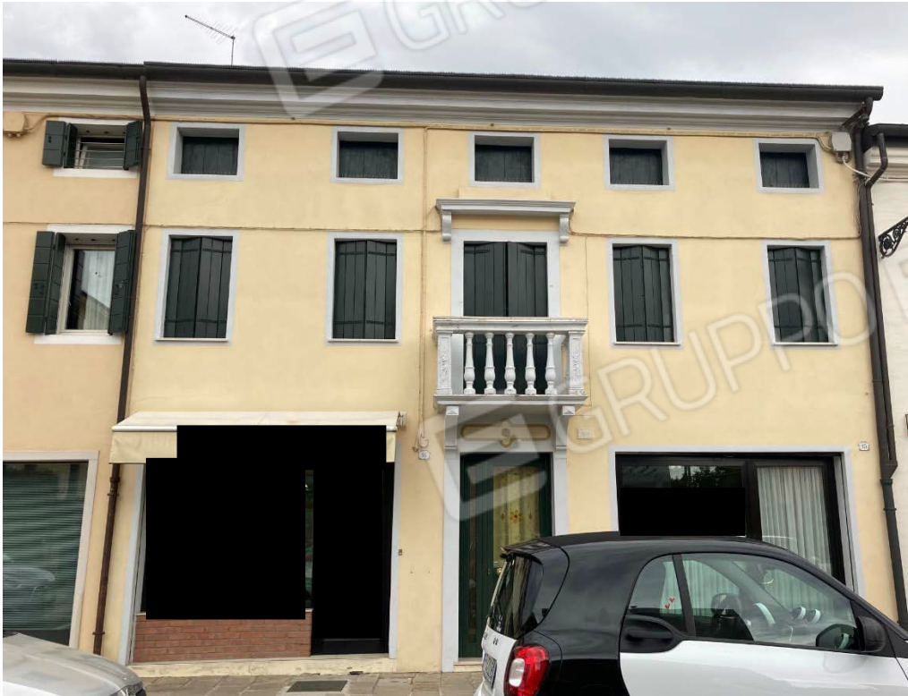
Foto n. 1: Vista del fabbricato
