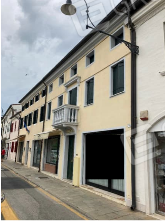
Foto n. 1 Vista del fabbricato
