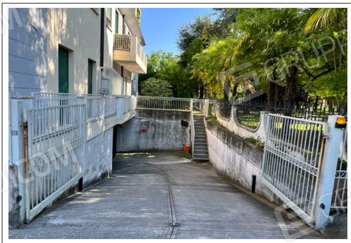
Fotogramma 2/5– Particolare dell'accesso carraio e della rampa.
