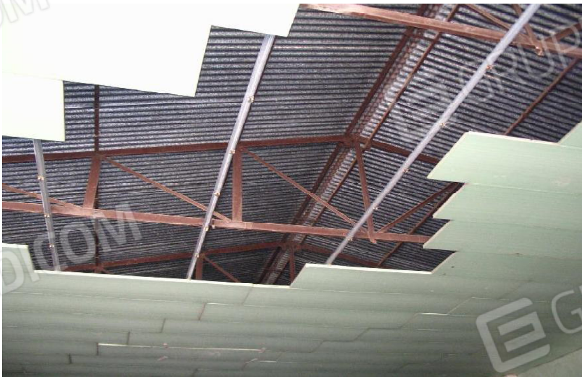
Foto 6 Interno capannone copertura
