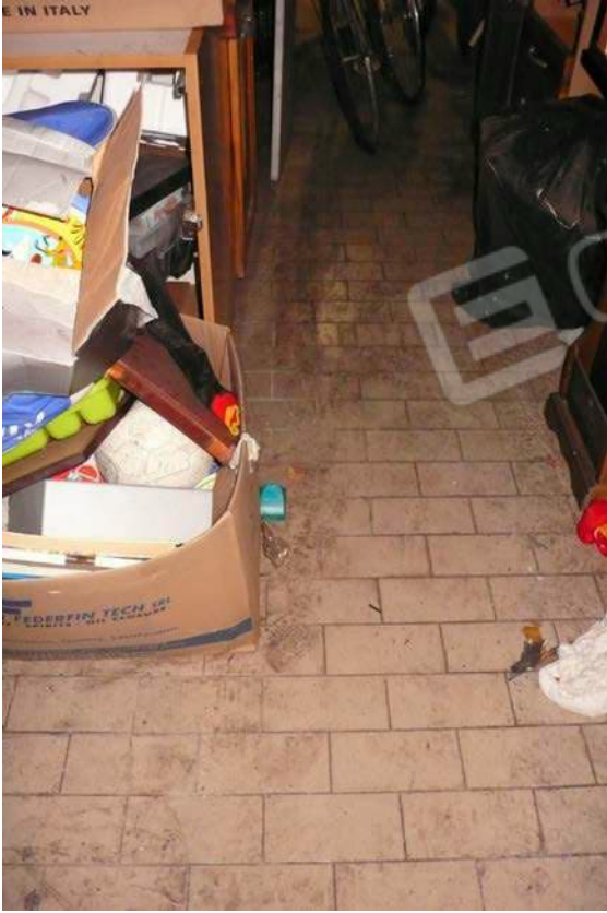
Foto n. 17 – magazzino al P.T.
