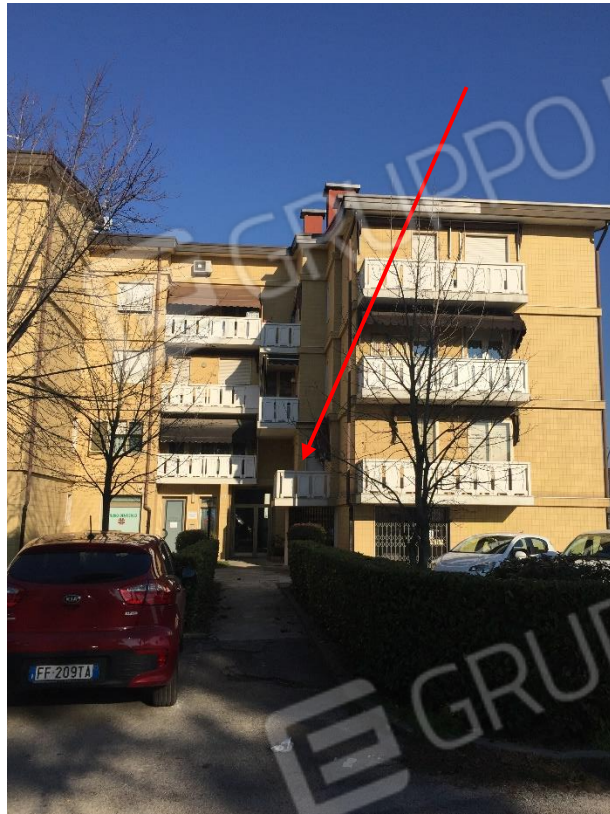
Fronte sud angolo est – Terrazzino in difformità
