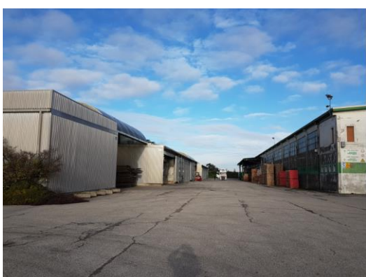
Edifici A (a sx) e B (a dx) da ovest
