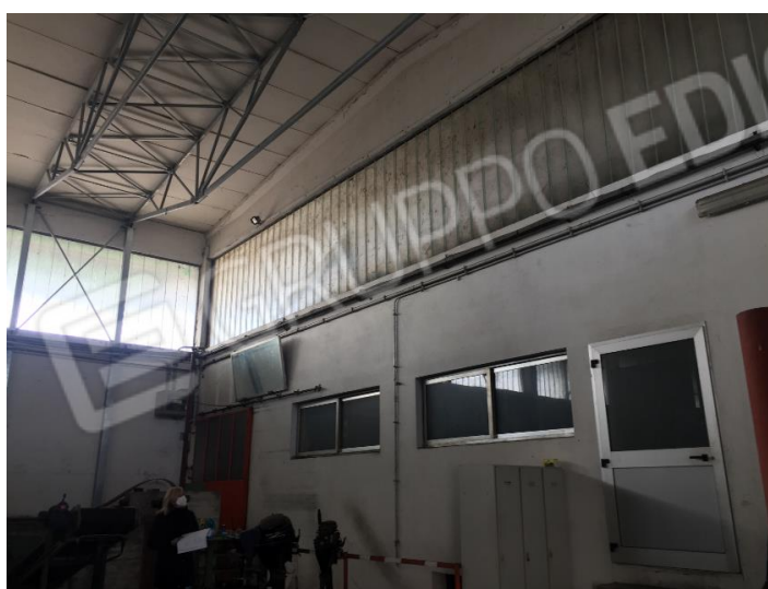
Area ad est su due livelli Edificio B
