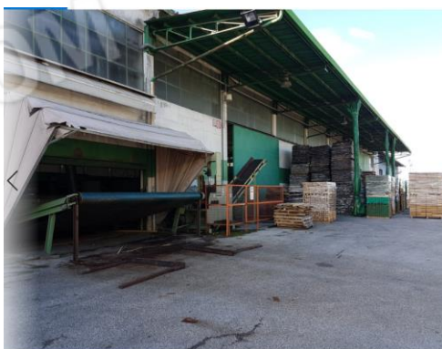
Edificio C lato nord e pensilina C1
