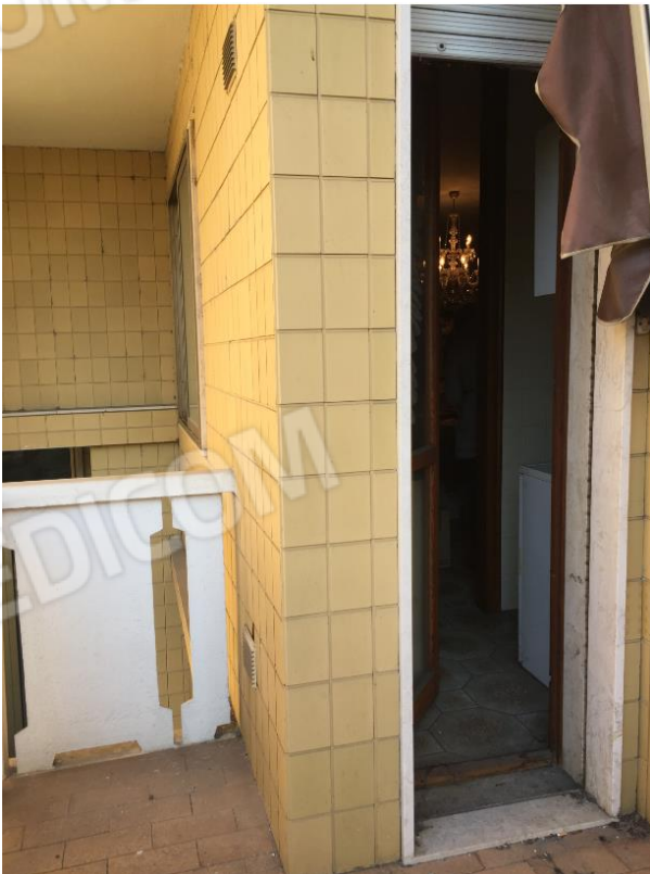
Poggiolo ad ovest (si veda punto 4)
