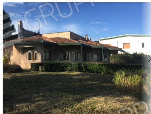
Lato nord est via Romea
