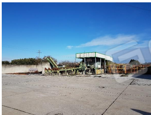
Piazzale area nord ovest
