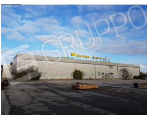
Edificio A visto dalla Romea
