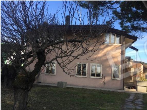
Lato sud est via Onari
