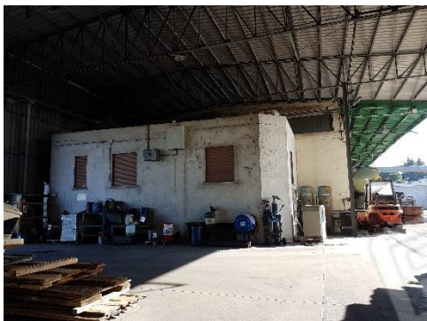
Area affilatura all'interno dell'edificio B
