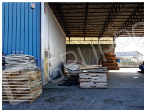
Pensilina tra edificio B ed edifici C e D
