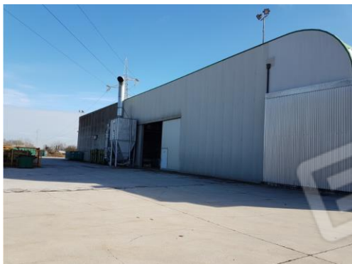
Lato Ovest edificio A
