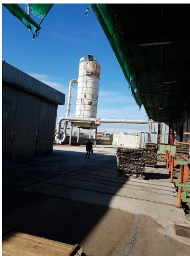
Silos (Edificio E)
