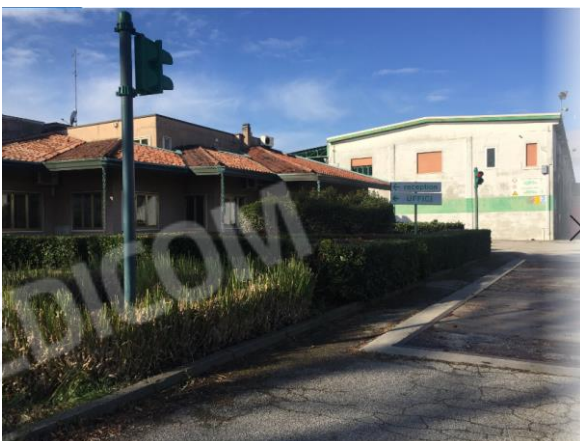
Lato nord interno area
