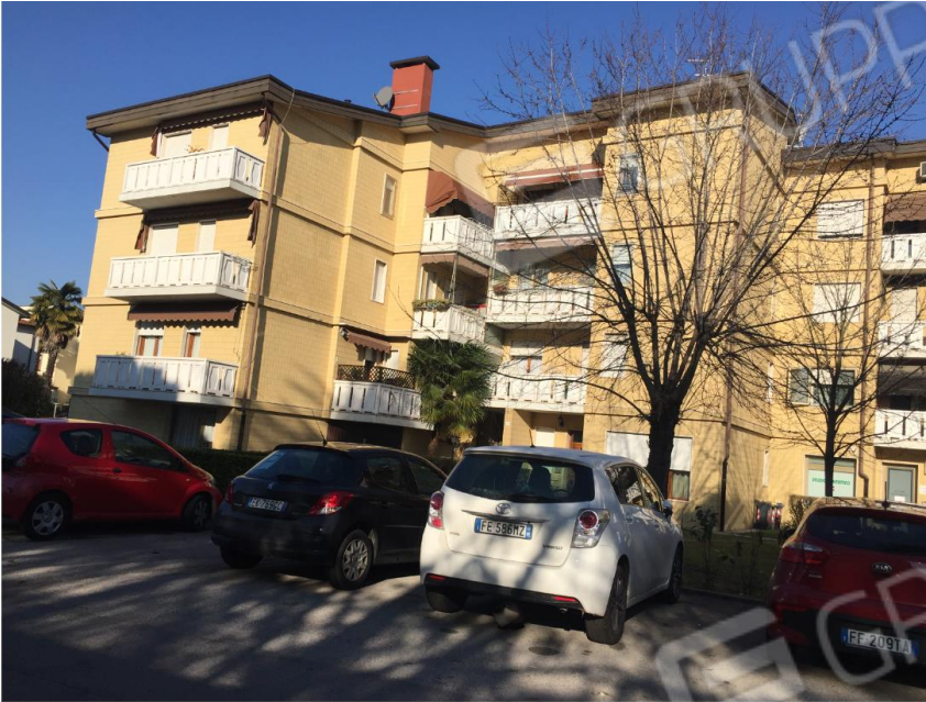
Fronte principale a sud
