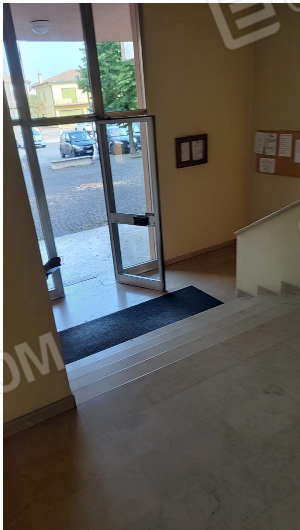
Foto 3 – ingresso principale su piazza A.Moro
