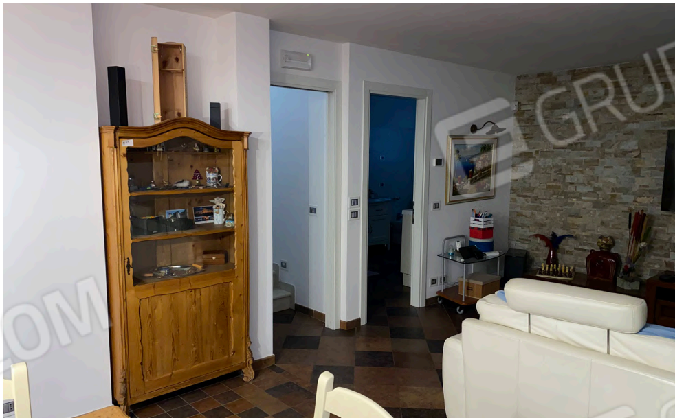
Foto 16: Piano interrato, porte del vano scala e del bagno
