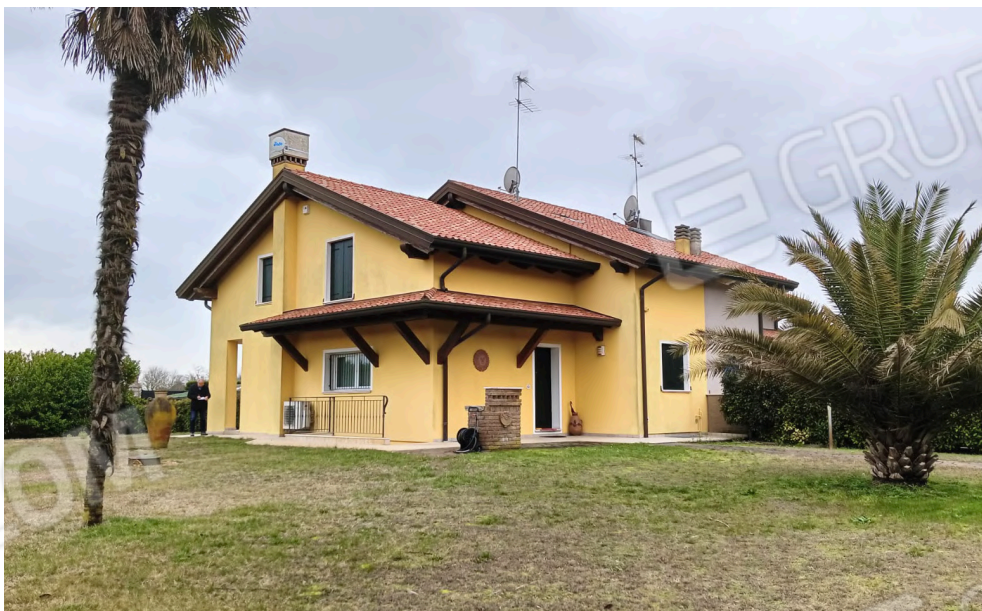
Foto 4: Foto dell'abitazione da Nord-Est
