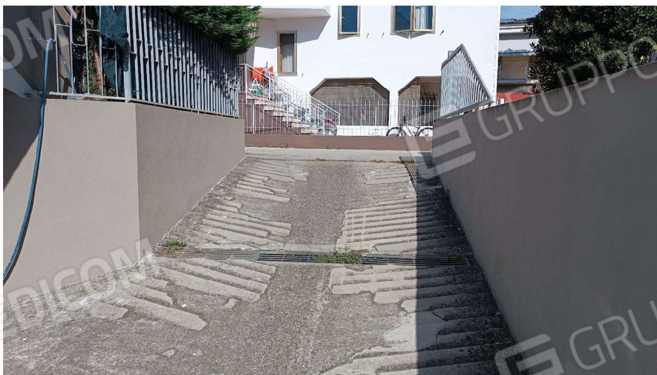
Foto 20 Rampa di accesso per autorimessa
