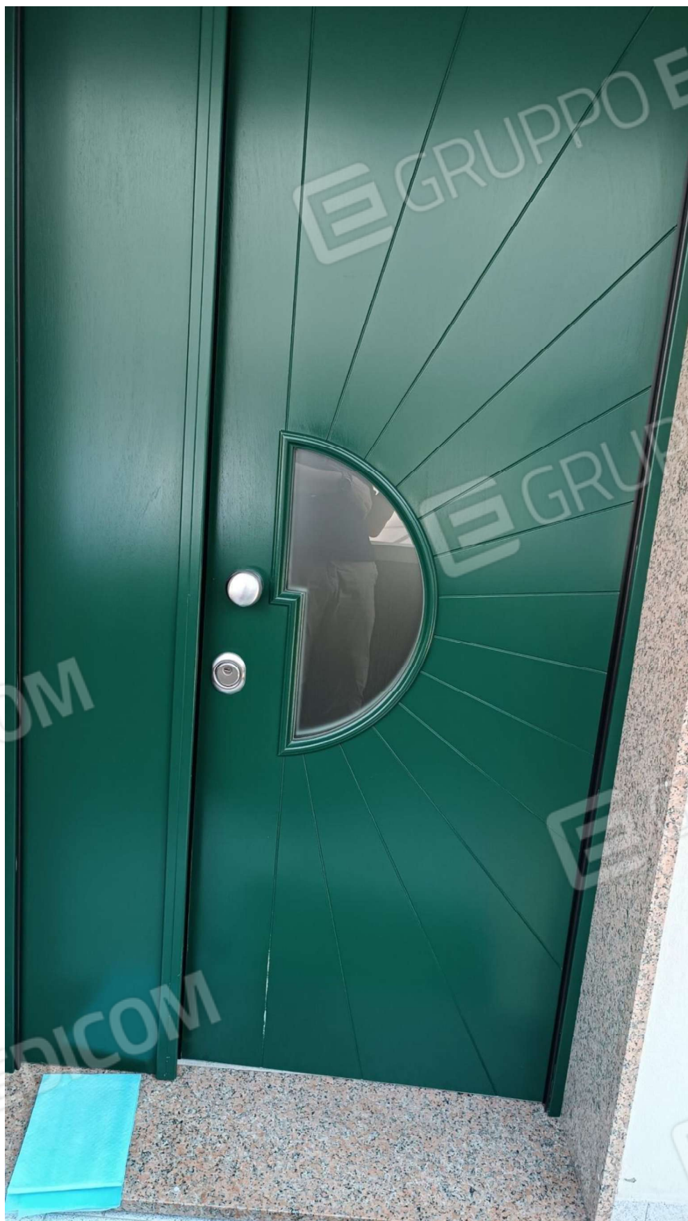
Foto 7 Porta blindata accesso all'unità abitativa
