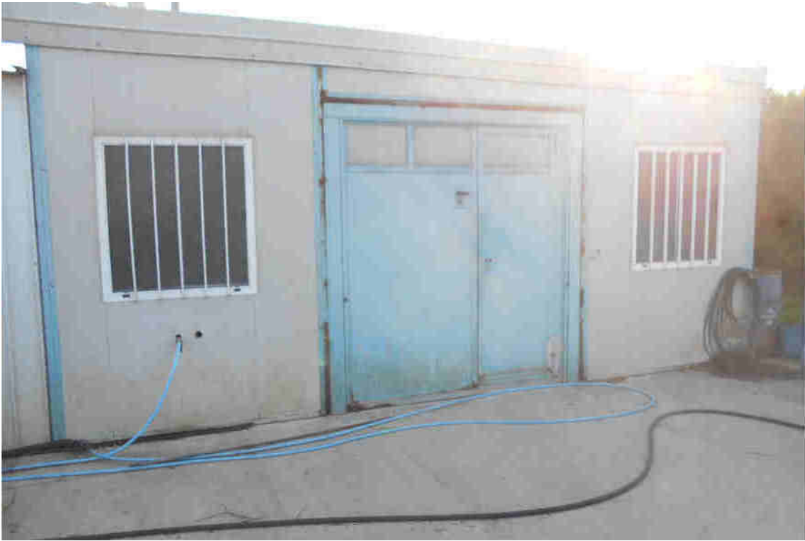
manufatto prefabbricato lato lavaggio automezzi
