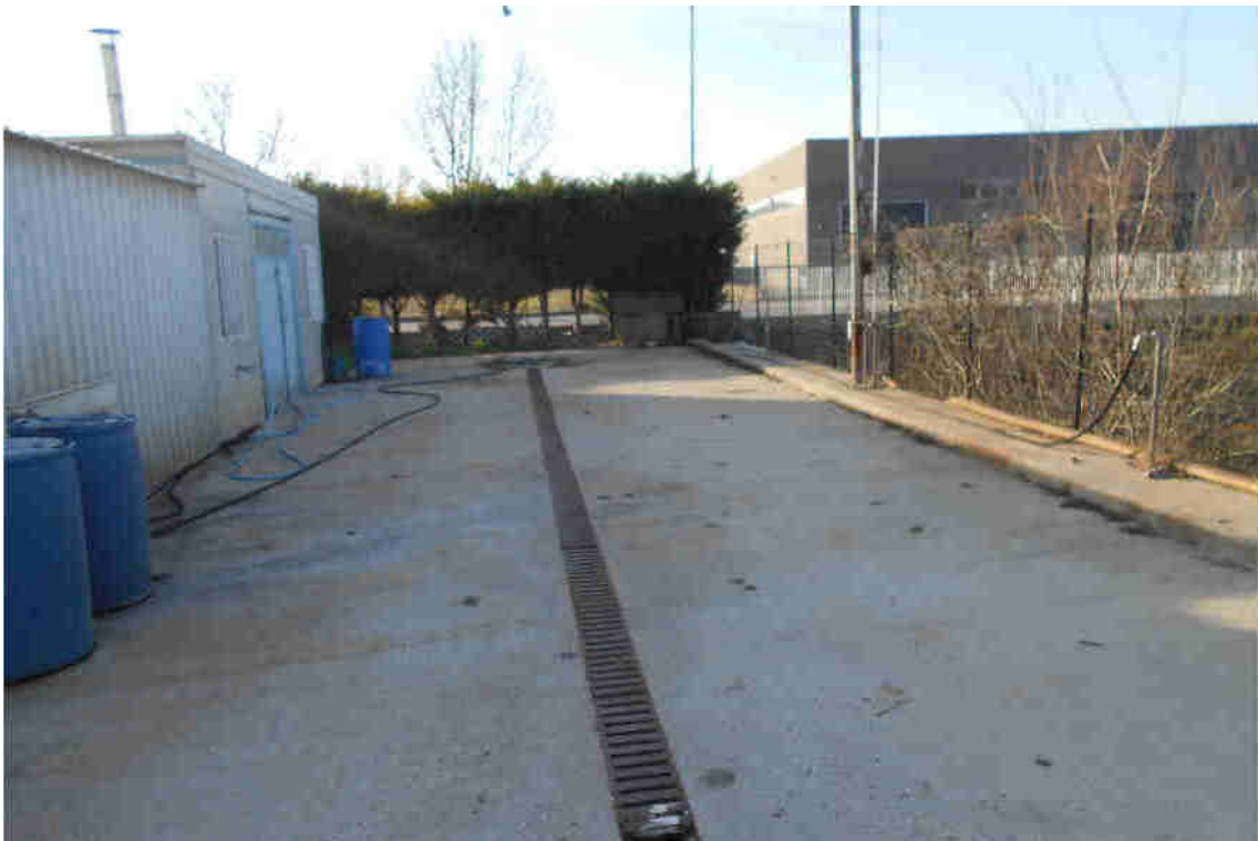
vista area lavaggio automezzi con manufatti prefabbricati
