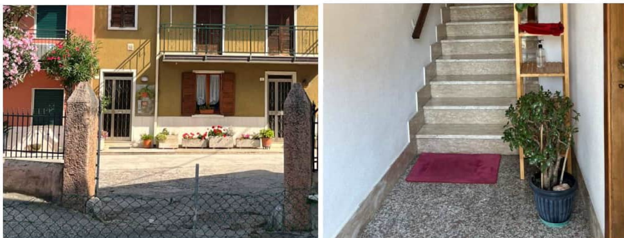
Ingresso: vista esterna e vista interna
