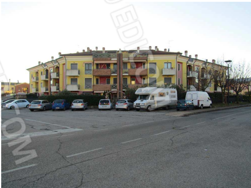
Foto 1: vista d'insieme del fabbricato da via Venezia, da nord-est
