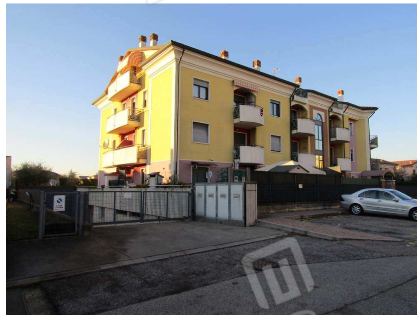
Foto 2: vista d'insieme del fabbricato da sud
