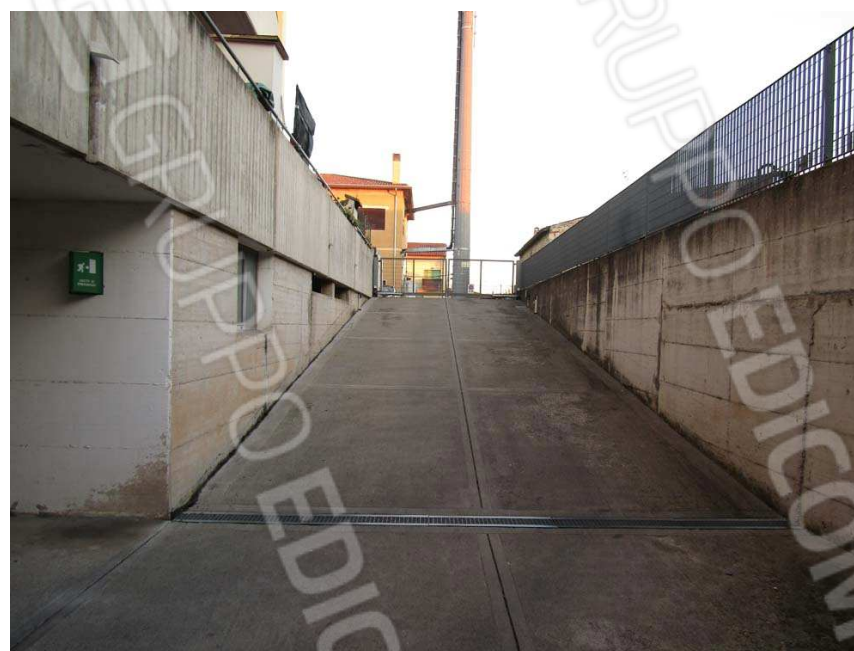
Foto 20: vista della rampa carraia condominiale
